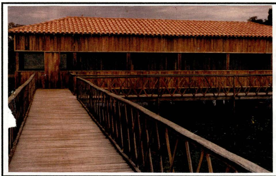
**Foto 13: Habitação construída em palafita com cobertura de telha de cerâmica.**
