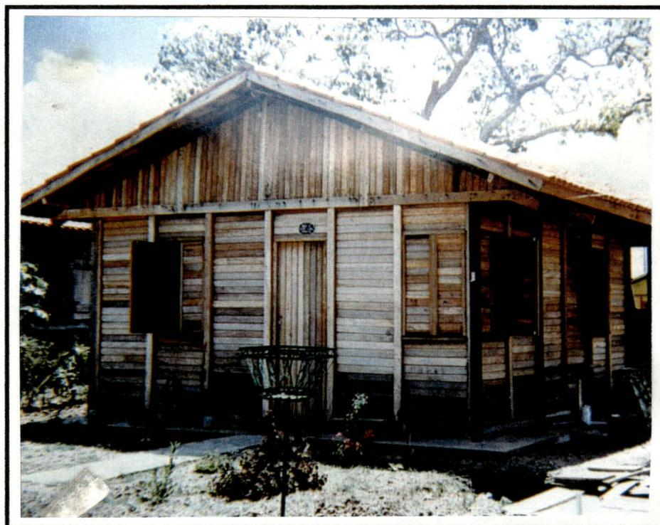
**Foto 23: Habitação modelo com painel portante construído em radier.**
