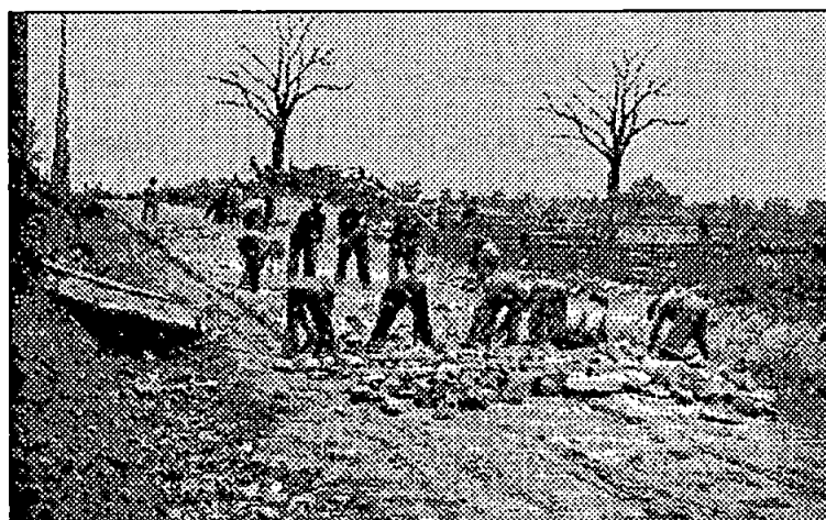
FOTO 4.2- Construção de uma base Telford no condado Mercer, em 1911. (HEWES & OGLESBY, 1954).
