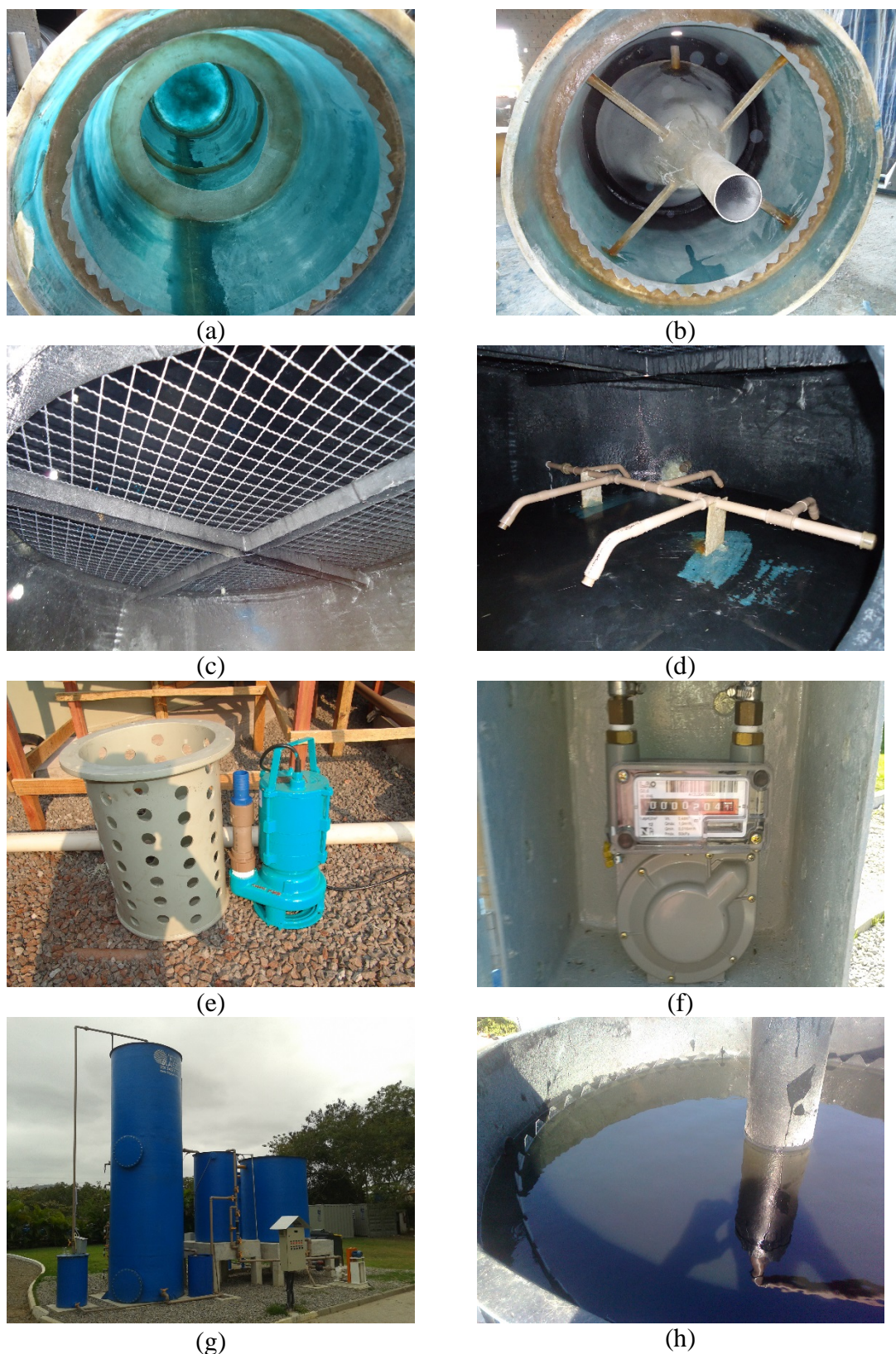
Figura 4.5 – Fotos da fabricação e montagem do reator piloto: (a) fabricação das estruturas de sustentação do leito, defletor e calha de saída; (b) instalação do separador trifásico; (c) instalação da tela de sustentação do leito; (d) montagem do ramal de alimentação; (e) bomba de alimentação e cesto de proteção; (f) medidor de biogás; (g) instalação e montagem eletromecânica concluídas; e (h) reator piloto em operação.
