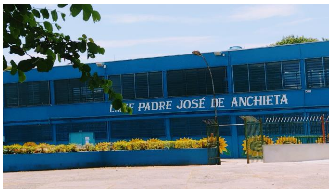
Figura 3- EMEF Padre José Anchieta localizada na rua Inajá- Guaçu. Fonte: Costa (2023).
