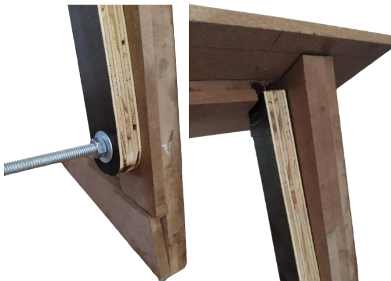
Figura 83.3.4.2.2 – detalhe sistema de regulagem de altura
