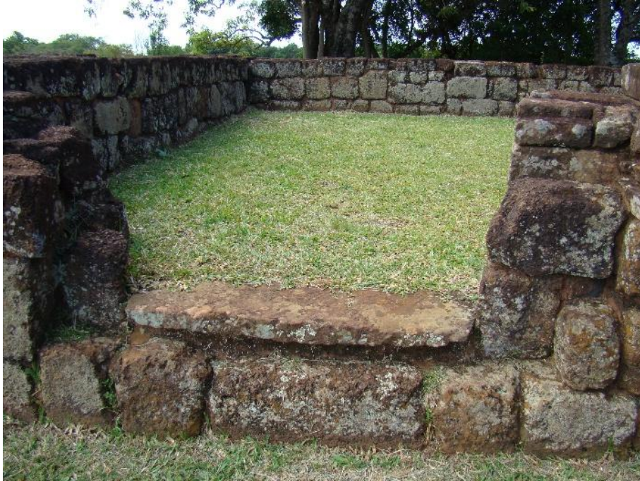
Figura 80 - Traçado Regular, Materiais e Técnicas construtivas simbolizam uma arquitetura vernacular, econômica, simples, sólida, rústica, híbrida, sustentável – paredes do cubículo de alvenaria seca e cantaria de pedras canga – São Miguel das Missões – 1735 – RS – Fotografia de Rogério Entringer – 2013
