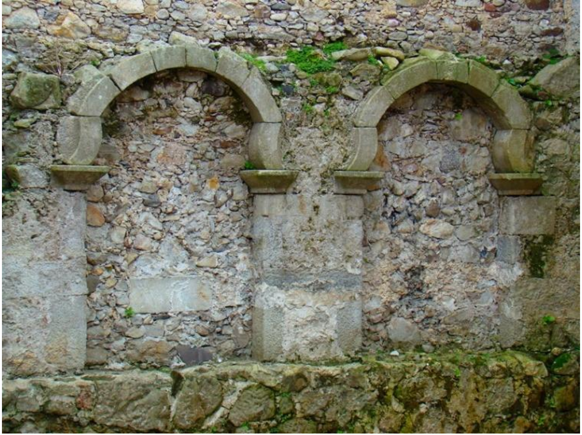
Figura 78 - Traçado Regular, Materiais e Técnicas construtivas simbolizam uma arquitetura vernacular, econômica, simples, sólida, rústica, híbrida, sustentável – parede e arcos de alvenaria mista de pedras irregulares e cantaria – antigo Colégio de Paranaguá – 1740-59 – PR – Fotografia de Rogério Entringer – 2013
