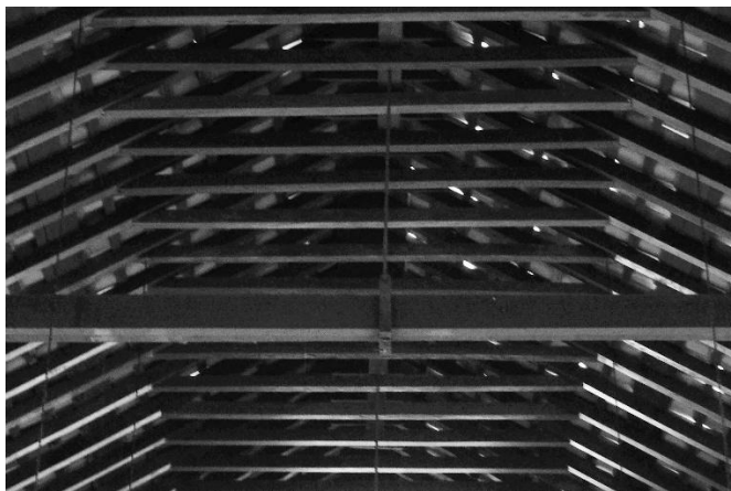
Figura 73 - A cruz como traçado regulador – caibros, ripas, vigamentos – materiais e estrutura do telhado da Igreja de São Lourenço dos Índios – 1769 – Niterói - RJ – Fotografia de Rogério Entringer - 2012
