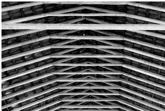
Figura 71 - A cruz como traçado regulador – caibros, ripas, vigamentos – materiais e estrutura do telhado do Colégio dos Reis Magos – 1580-1615 – Nova Almeida – ES – Fotografia de Rogério Entringer – 2012
