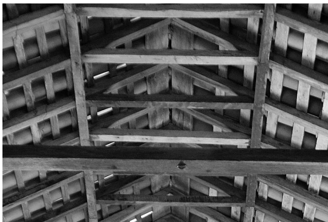
Figura 72 - A cruz como traçado regulador – caibros, ripas, vigamentos – materiais e estrutura do telhado da Igreja de São Pedro da Aldeia – 1723 – RJ – Fotografia de Rogério Entringer - 2012
