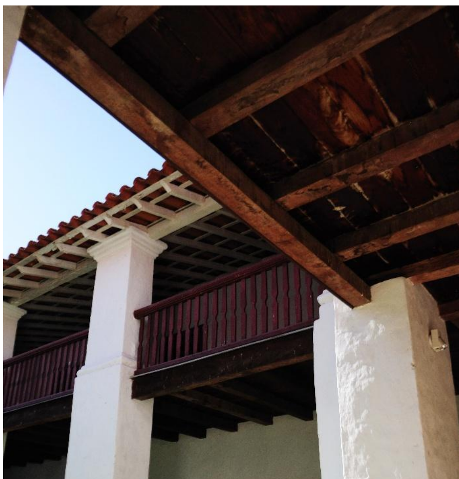
Figura 74 - A cruz como traçado regulador – caibros, ripas, vigamentos – materiais e estrutura do barrote do Colégio Reis Magos – 1580-1615 – Nova Almeida - ES – Fotografia de Rogério Entringer - 2012
