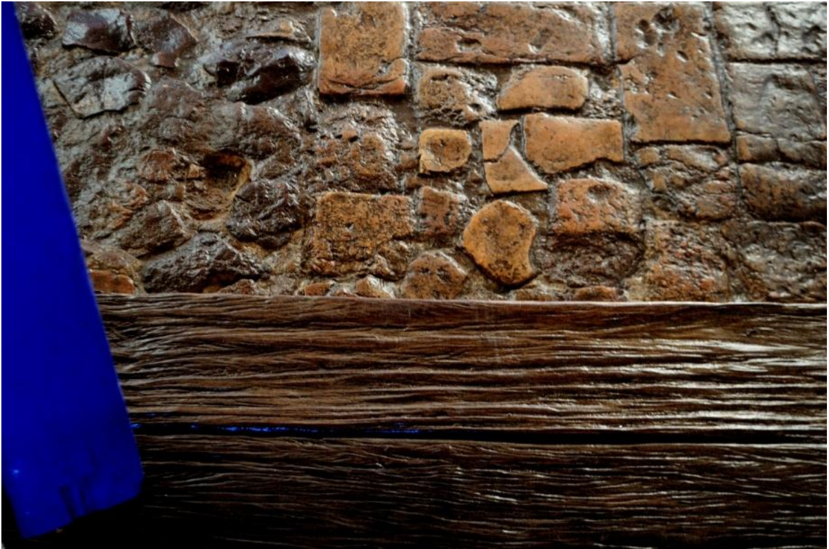
Figura 77 - Materiais e técnicas construtivas simbolizam uma arquitetura vernacular, econômica, simples, sólida, rústica, híbrida, sustentável – Soleira de madeira e piso misto de barro e pedra – Colégio Reis Magos – 1580 – 1615 – Nova Almeida – ES – Fotografia de Rogério Entringer – 2012
