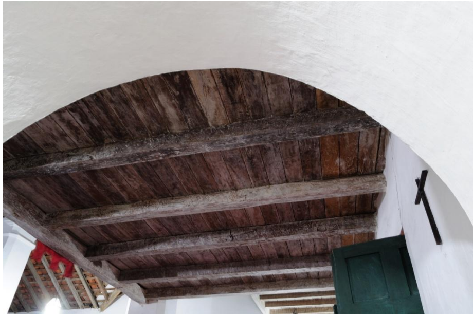
Figura 75 - A cruz como traçado regulador – caibros, ripas, vigamentos – materiais e estrutura do barrote da Igreja de São Pedro da Aldeia – 1723 – RJ – Fotografia de Rogério Entringer - 2012
