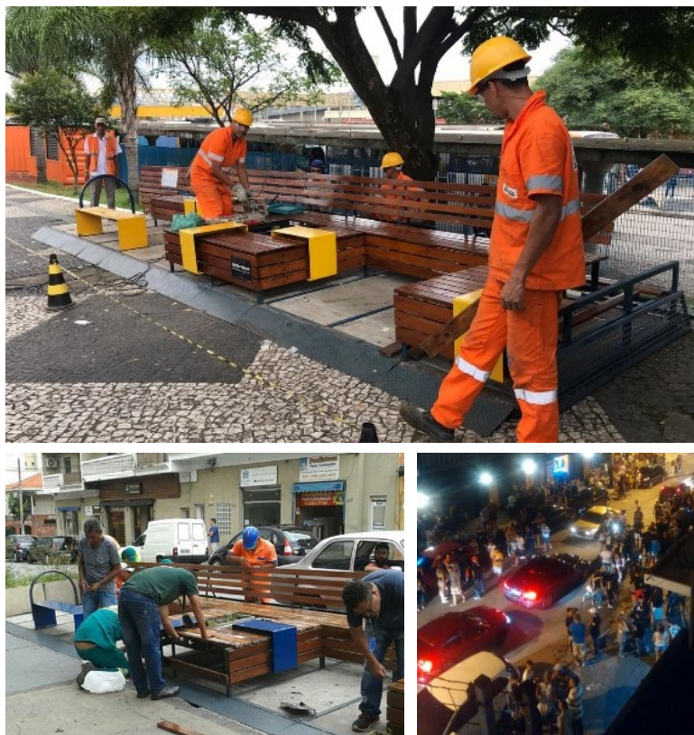
FIGURAS 68-70 - Transferências do parklet municipal de Guaianases (para calçamento pavimento, sem vaga de estacionamento) e remoção em Aricanduva devido à sua apropriação noturna pela população jovem. Fontes: e-SIC São Paulo e SPJornal.
