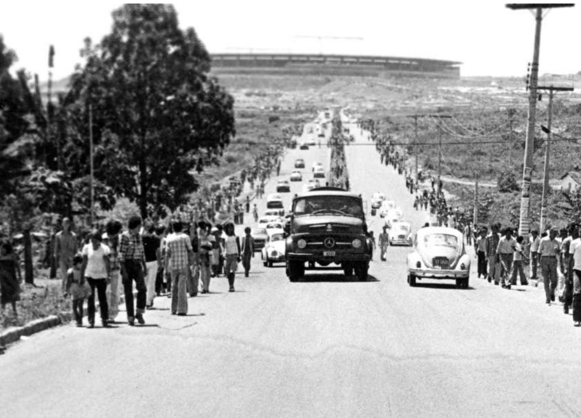
Figura 11 - Trabalhadores na construção do Estádio Serra Dourada em 1972. Fonte: Jornal O Popular, data. Acesso: março de 2024.
