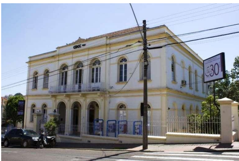
Figura 4 – Edifício CDCC atual
