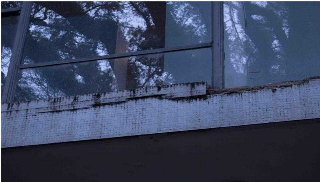
Figura 33 – Fotografia do desprendimento e degradação das pastilhas e parte da argamassa de revestimento da fachada do Museu Afro Brasil. Fonte: autor, 2018
