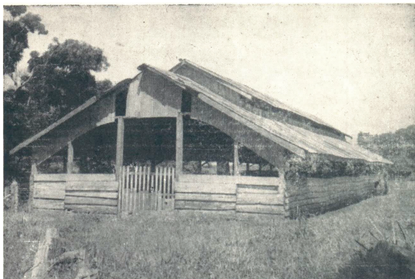
Figura 7 Vista externa do galpão
