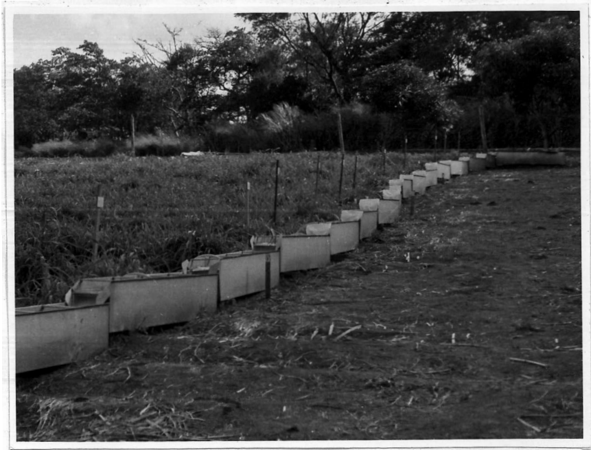
FIG. 2 - Condução da água por meio de calhas de chapas galvanizadas, colocadas escalonadamente na cabeceira dos sulcos.
