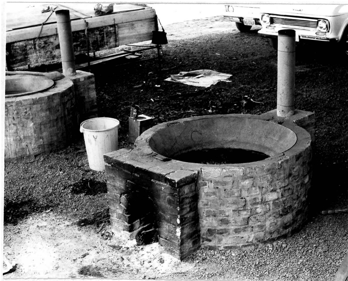
Figura nº 14. Forno usado na secagem do lodo. Estação Experimental de Araras, 1972.
