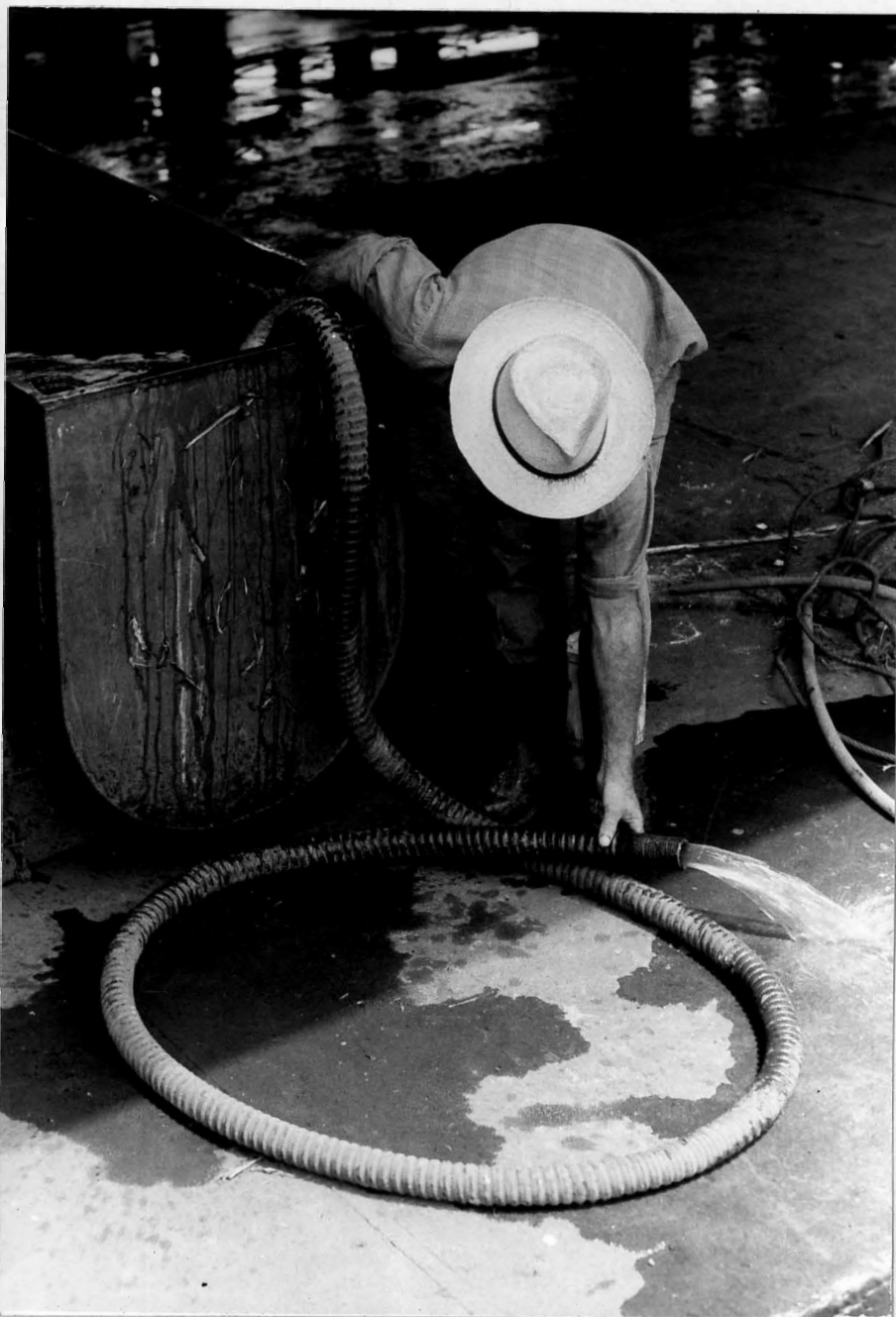
Figura nº 12. Sifonagem da água de lavagem para a separação do lodo. Usina São João , 1972.
