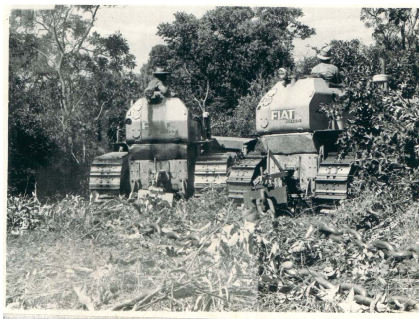
Figura 5.2.- Tratores equipados com lâminas angledozer e correntão, utilizados nos ensaios de desmatamento na Fazenda Globo, em Agudos, SP.
