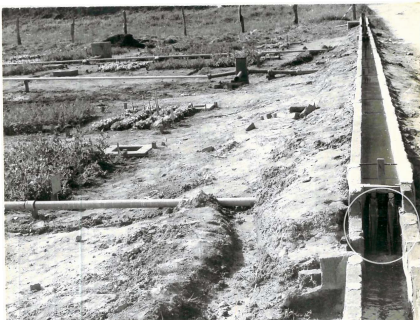
Fig. 5 No círculo, comporta regulável provida de extravasores para a barragem de água no canal secundário.
