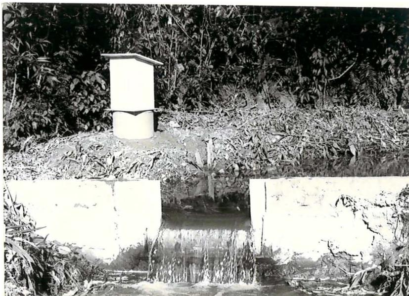
Fig. 9. Detalhe do vertedor de seção retangular utilizado na Bacia Hidrográfica do Palmital.
