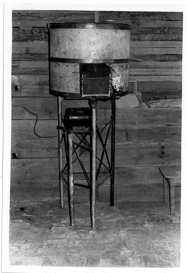
FOTOGRAFIA 15. - Vista frontal do alimentador vibratório, mostrando cuba circular, sistema vibratório e armação.
