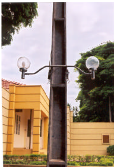
Figura 3 - Sistema de iluminação pública rebaixado, Maringá/PR.
