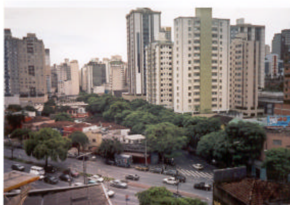
Figura 5 - Rua arborizada em sistema de distribuição subterrâneo de energia elétrica na cidade de Belo Horizonte/MG.
