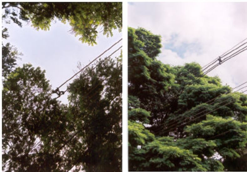
Figura 2 - Espaçadores em arranjo triangular, Maringá/PR.
