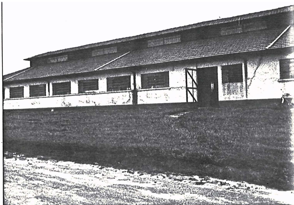
FIGURA 1 - Vista externa do galpão experimental utilizado em Nova Odessa, Estado de São Paulo.
