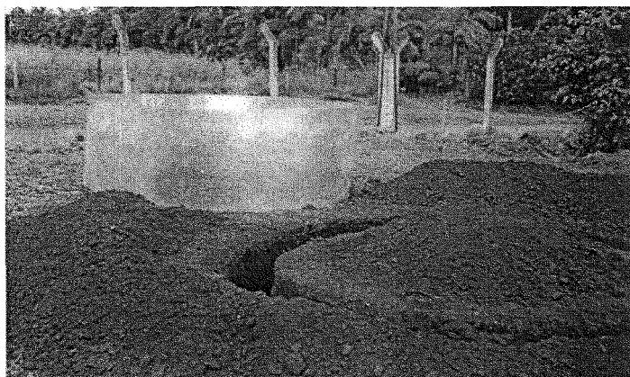
Figura 5 - Chapa galvanizada utilizada e abertura do solo para a sua introdução
