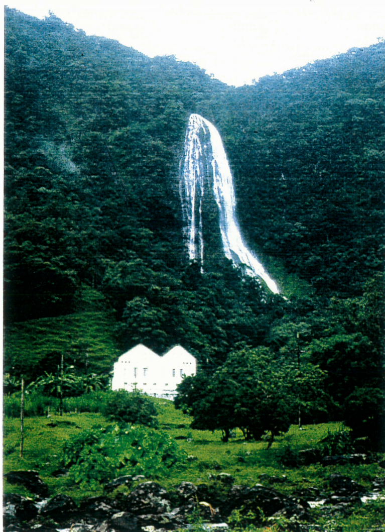
Figura 1: Estação Ecológica do Bracinho - vista frontal da Usina Piraf. Ao fundo queda d'água de 310 m de altura do rio Piraf.
