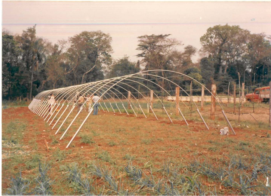
FIGURA 3. Fase de construção da casa de vegetação.
