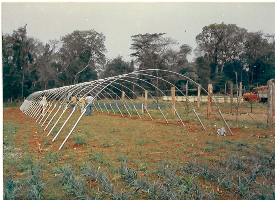
Figura 3. Estrutura da casa de vegetação.
