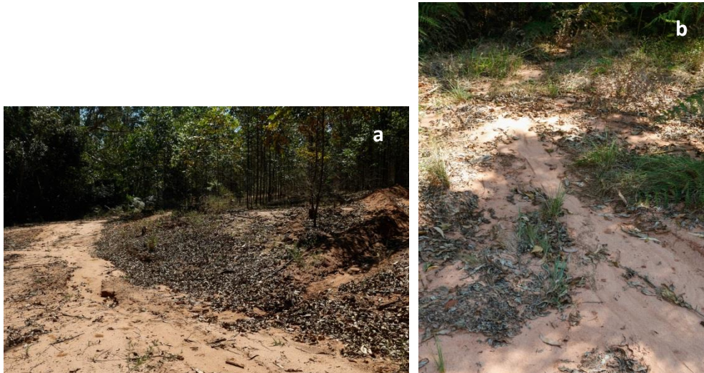
Figura 2.12 – Excesso de deposição de sedimentos (a) e rompimento dos bordos das estradas com direção ao córrego do Ita
