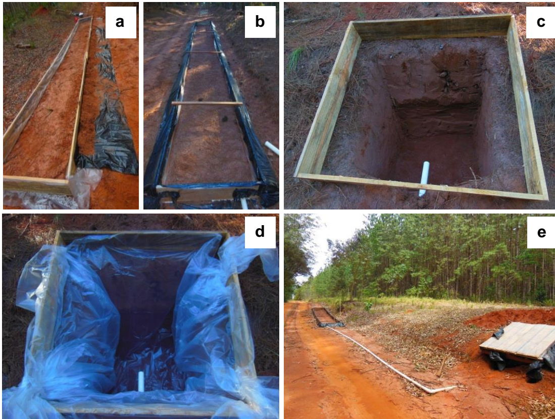
Figura 3.3 - Etapas da instalação das parcelas: vedação das bordas da caixa coletora com lona e solo (a e b), buraco feito para a instalação da caixa armazenadora (c) revestimento da caixa armazenadora (d) e conexão das duas caixas por meio de um cano de pvc (e)
