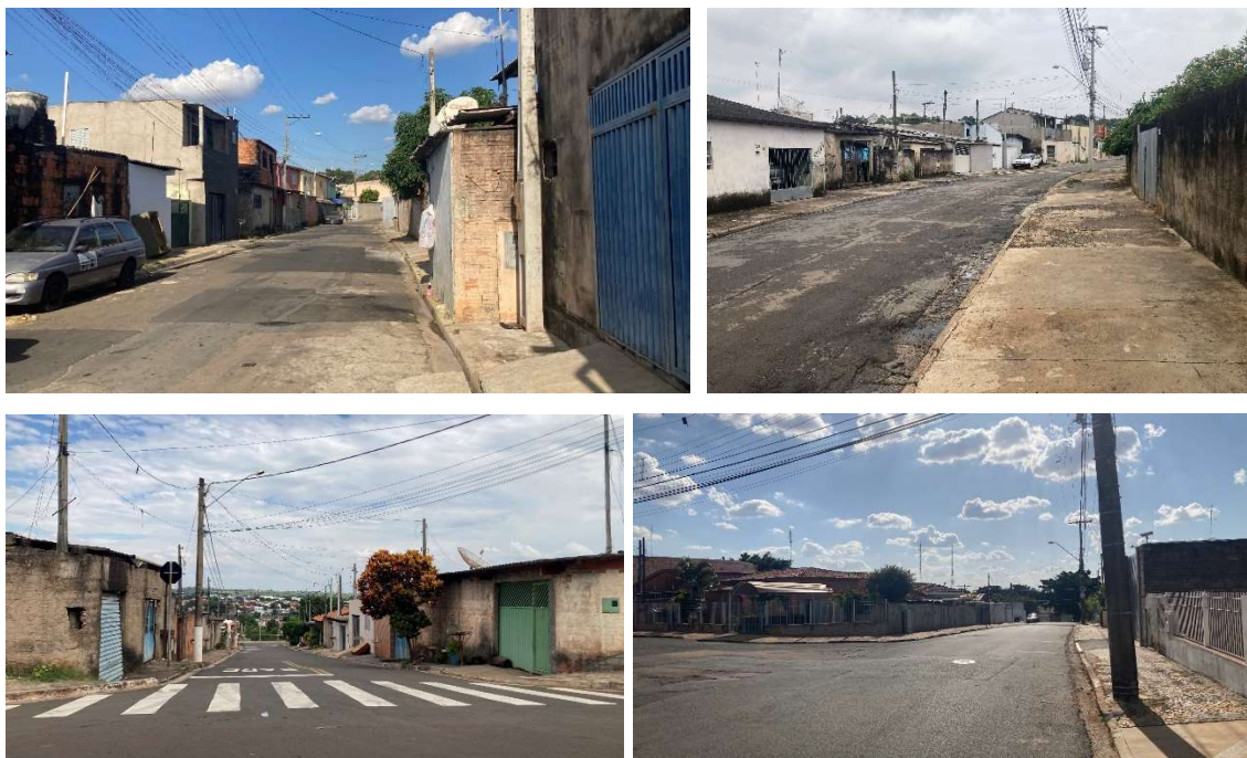
Figura 27. a) trecho de via sem calçada na Favelinha do Jardim Eulina b) calçada de 3 metros de largura sem nenhuma vegetação também na Favelinha c) e d) ruas do Vila Esperança e do Jardim Eulina, respectivamente. Fonte: a autora. Fotos do Loteamento Vila Esperança e do Bairro Jardim Eulina. Fonte: A autora.
