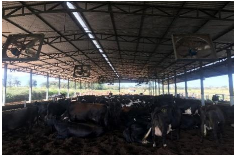
Figura 5. Estrutura do galpão de compost barn
