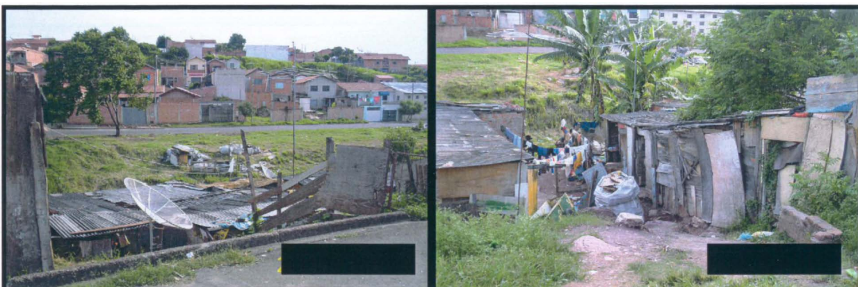
Figura 15 – Moradias dos Catadores em área de risco Fonte: Silva (pesquisador).
