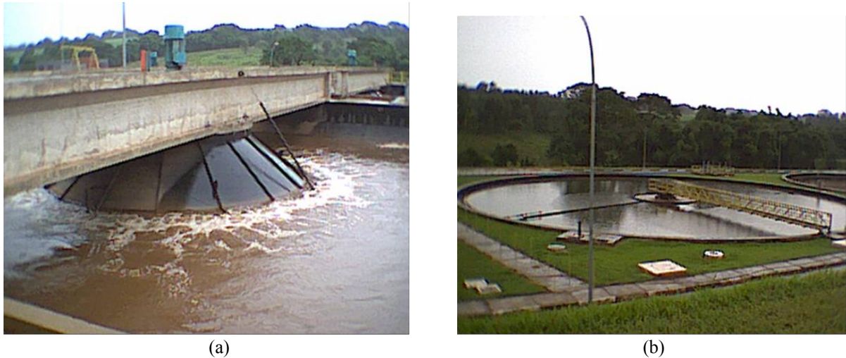
Figura 2.3 – Estação de tratamento de esgoto de Franca, SP, com lodos ativados: (a) tanque de aeração e (b) decantador
