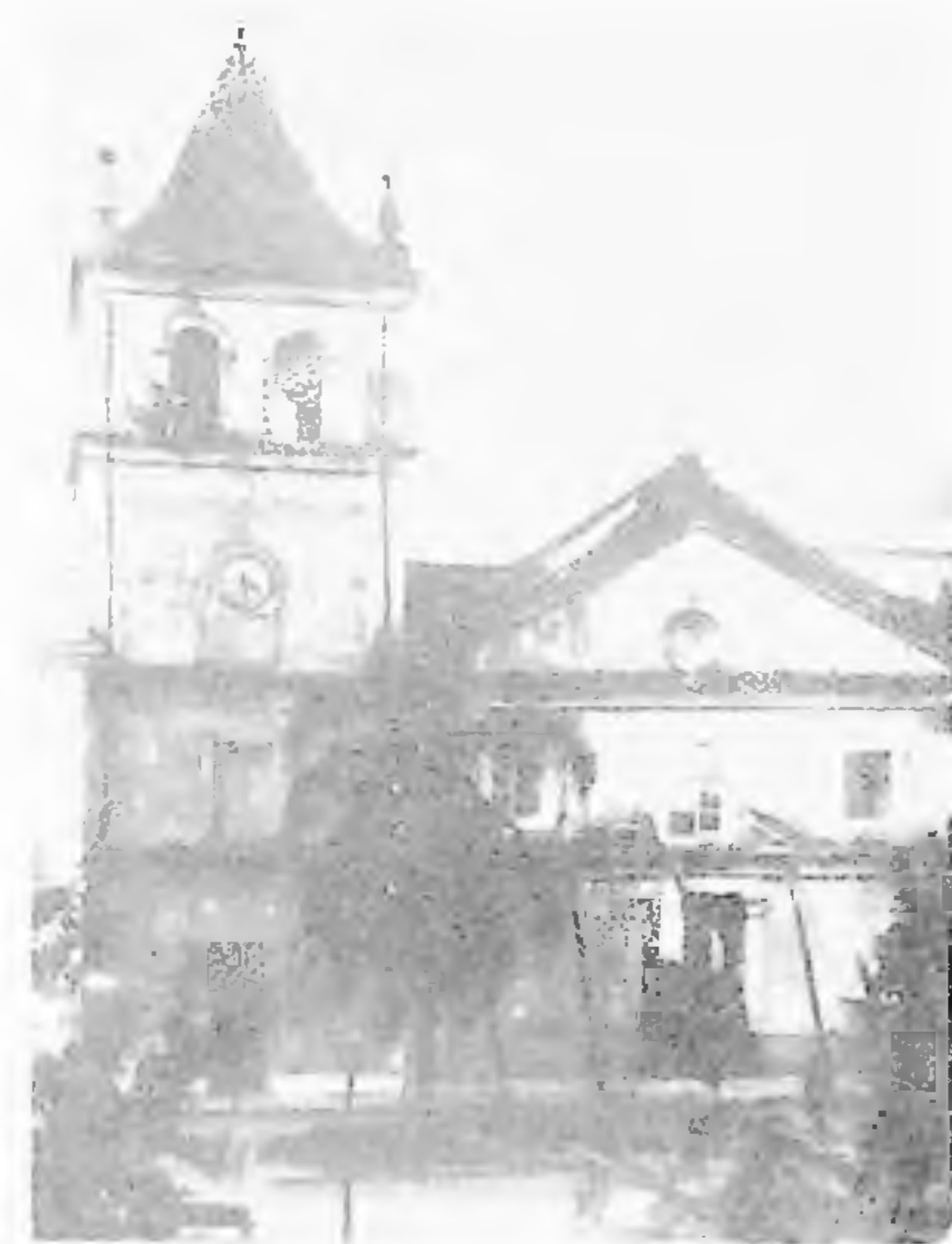
Última imagem da igreja do Colégio antes da demolição
