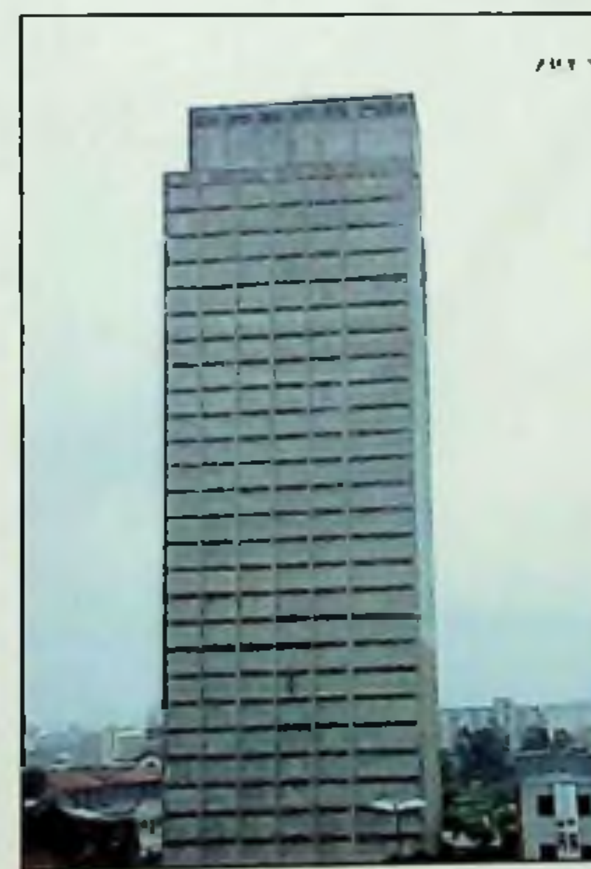
Edifício de estacionamentos utilizado como base para o Cruzeiro
