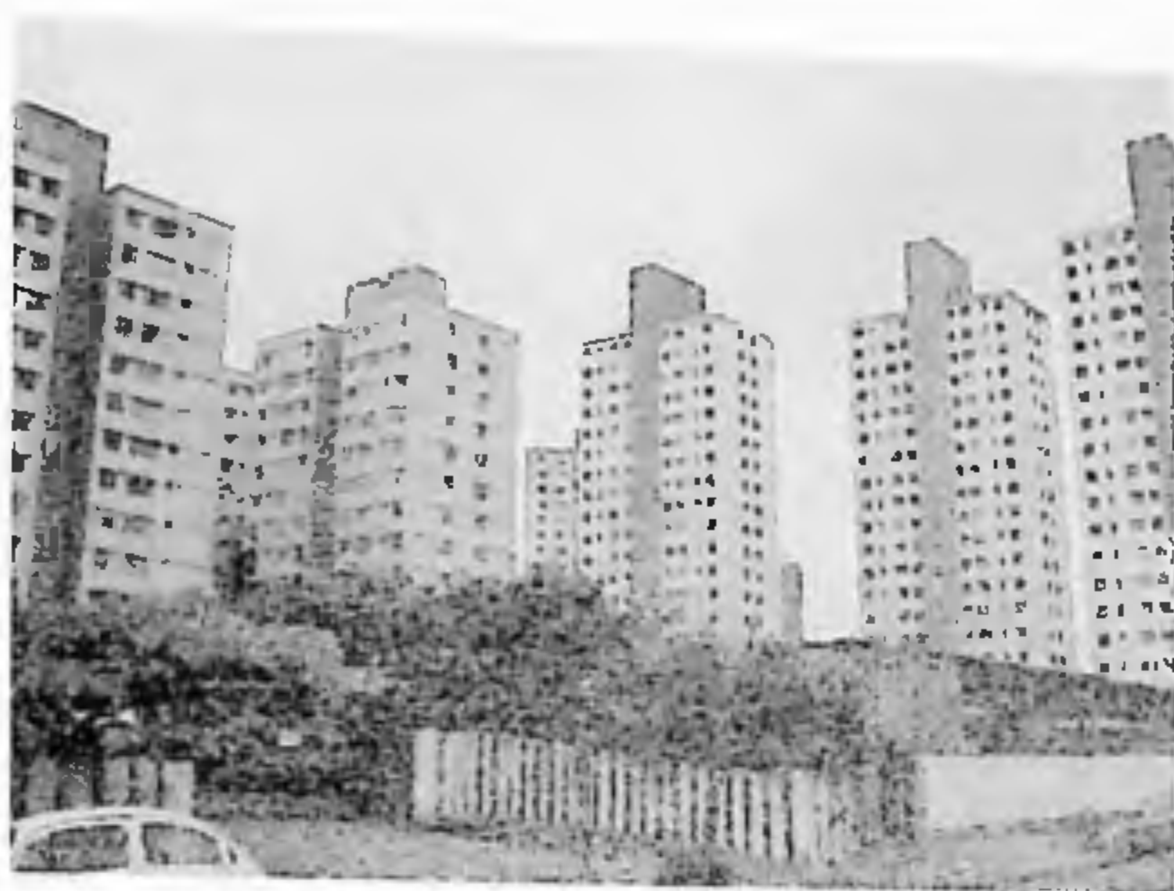
Conjunto Habitacional no Brás
