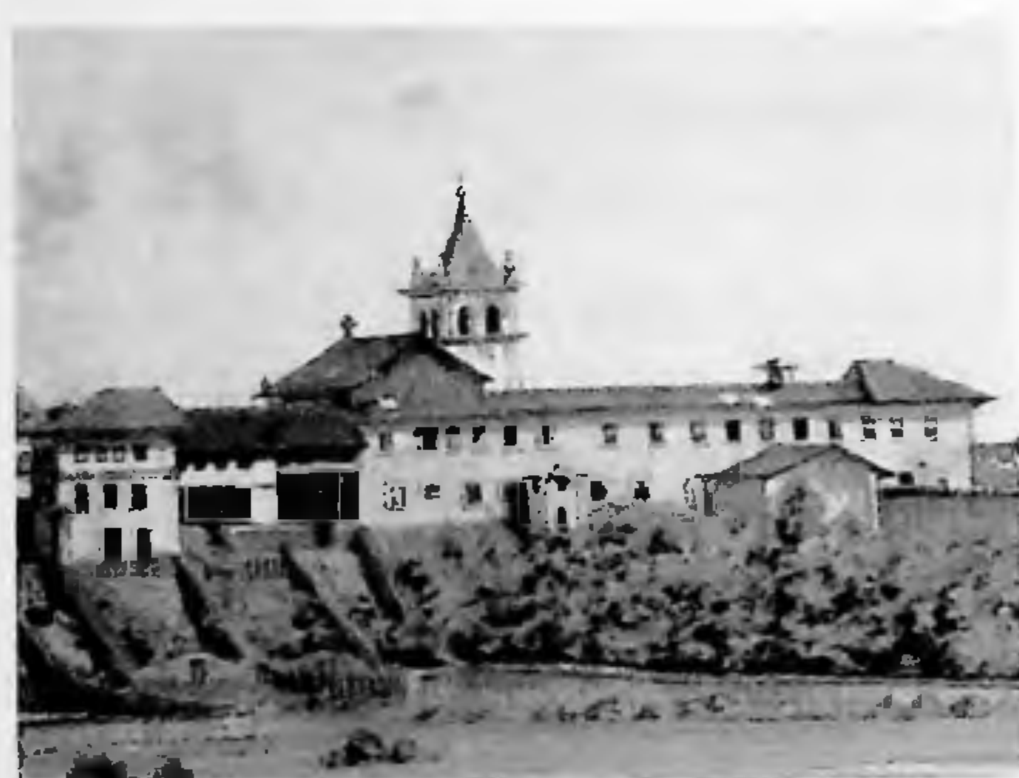
1821 aquarela A. J. Palière (detalhe) Vistas do complexo de edifícios desenvolvidos a partir do Colégio jesuítico
