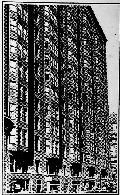
Figura II.7 O Monadnock Building de Chicago, 1891. Projeto de Burnham e Root. (CONDRI, CARL, 1952, )
