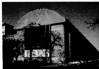
Fábrica de Turbinas AEG (1908-1909) Peter Behrens Fonte: GYMPEL, 2001, p. 84
