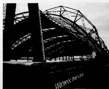
Terminal de Waterloo (1990-1993) Nicholas Grimshaw Fonte: Jodidio, 1997, p.59
