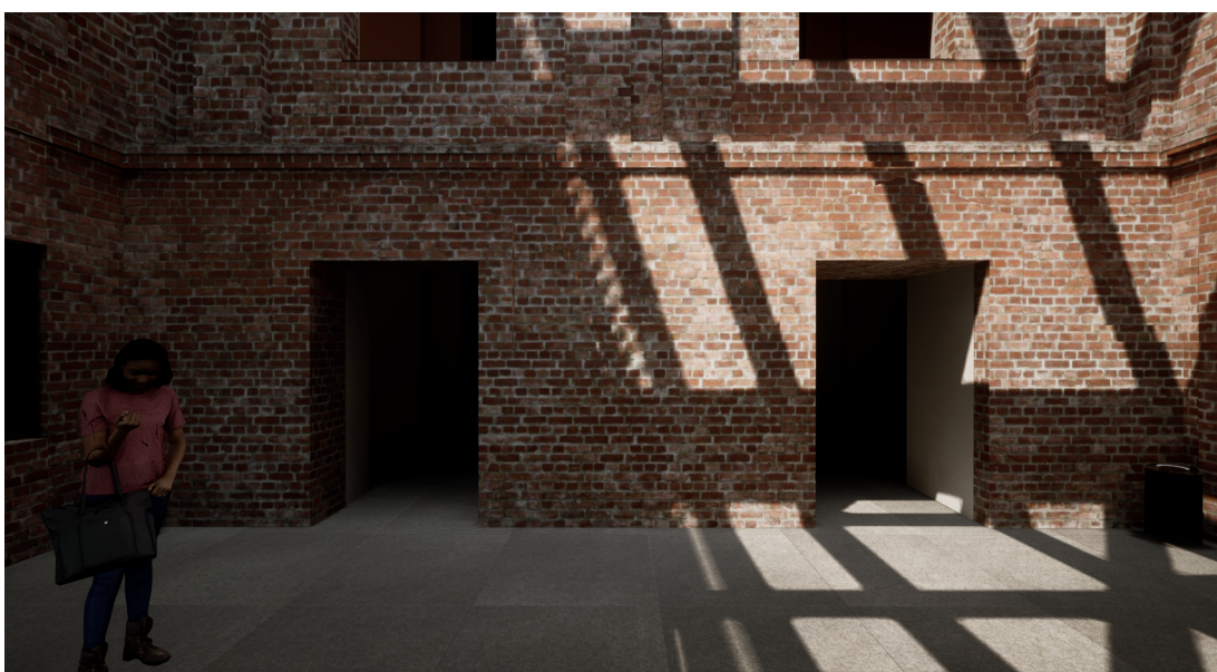
Figura 34: Incidência solar direta em paredes e piso. Elaborado pelo autor.
