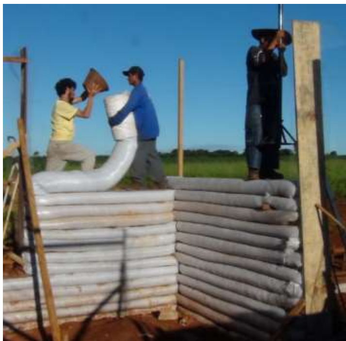
Figura A.13 - Construção de paredes com a técnica de terra ensacada, desenvolvida por Nader Khalili. Fonte: site Anaveraldo
