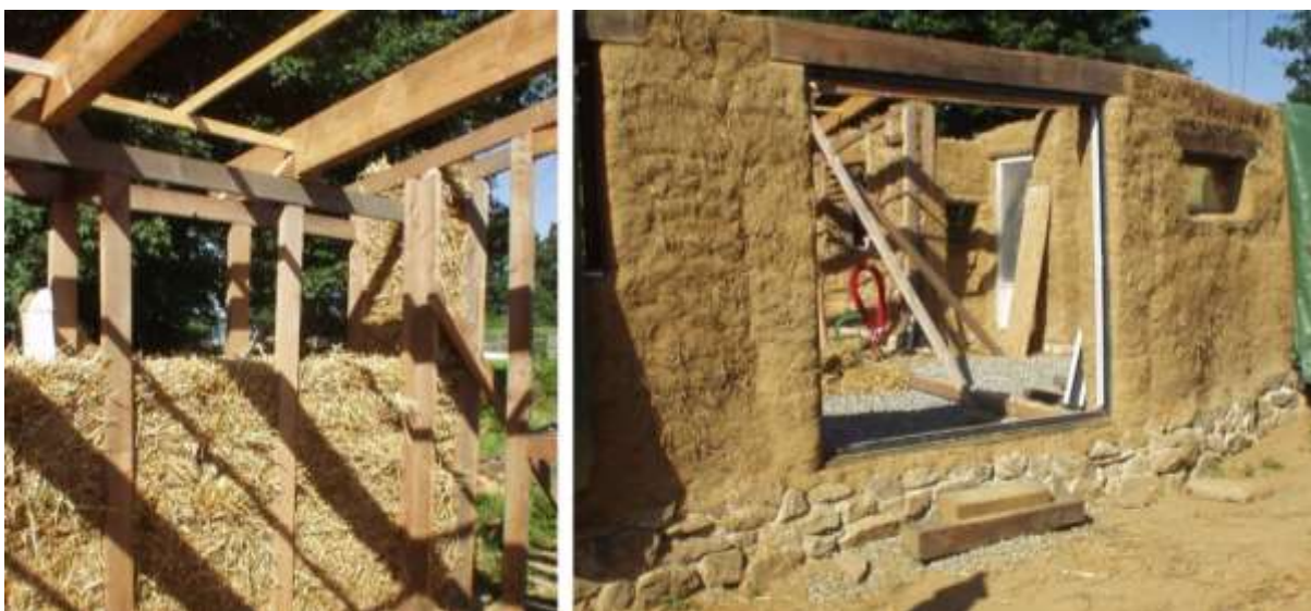
Figura A.12 - Construção de casa em Ille-et-Vilaine, França. Fonte: site Maison-cob-paille-bazouges
