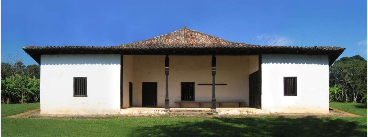
Figura 2.15 - Casa do Padre Inácio, construção bandeirista de 1753 na cidade de Cotia, São Paulo. Suas paredes "nascem" diretamente das fundações, também executadas com a técnica de taipa de pilão. Fonte: site Rota mogiana
