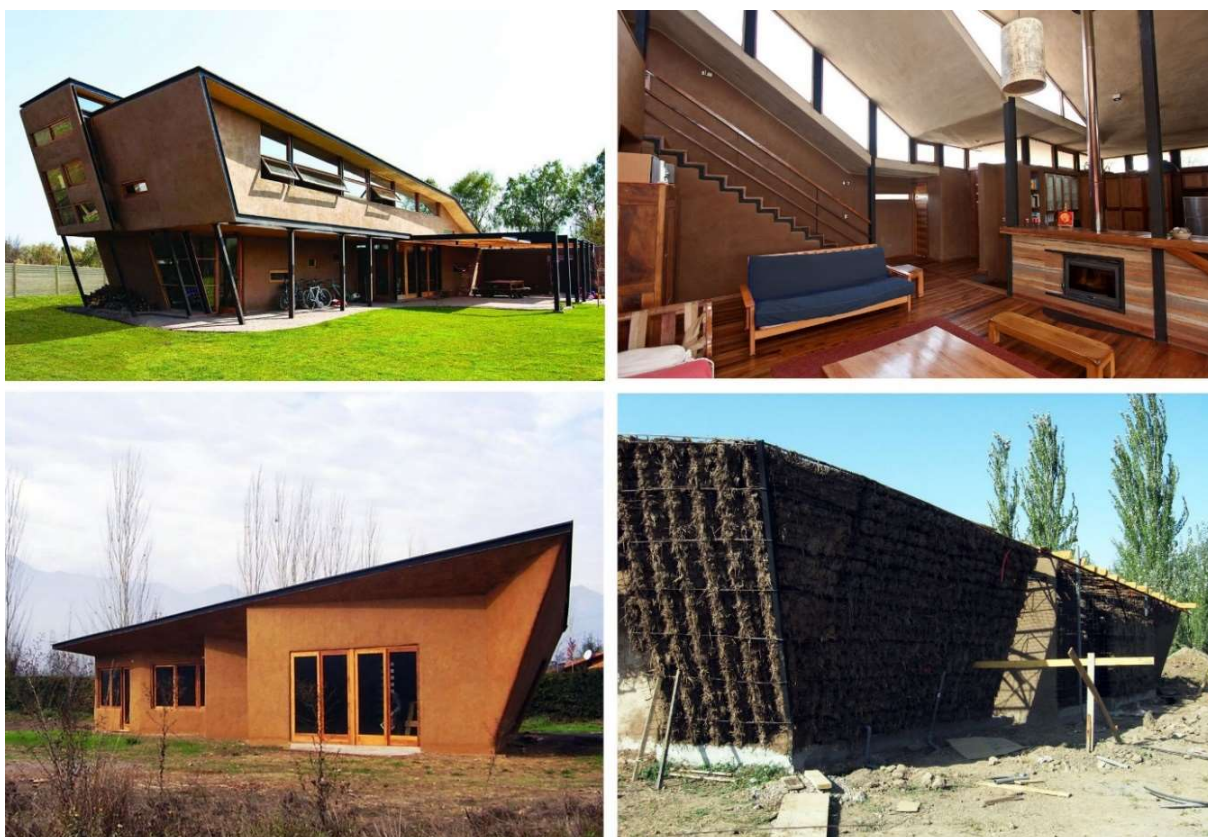
Figura 5.5: Residências projetadas e construídas pelo arquiteto chileno Patricio Arias Cortés (Surtierra), utilizando a técnica do tecno-barro. Casa Munita Gozalez (superior) e Casa Pirque (inferior). Fotos: site Sur Tierra Arquitectura
