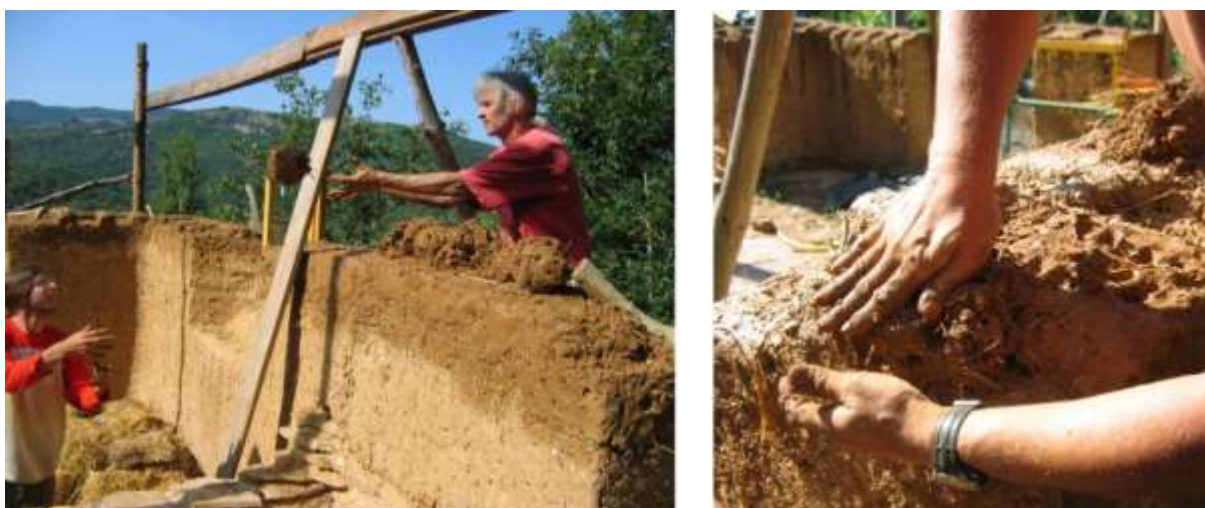
Figura A.4 – Execução de parede em Cob em construção na França: bola de terra sendo lançada e moldada na forma da parede. Fonte: site Roule maplume
