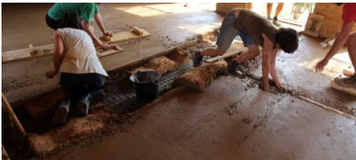
Figura A.2– Execução de piso em Terra Plástica. Fonte: site Margotclerc
