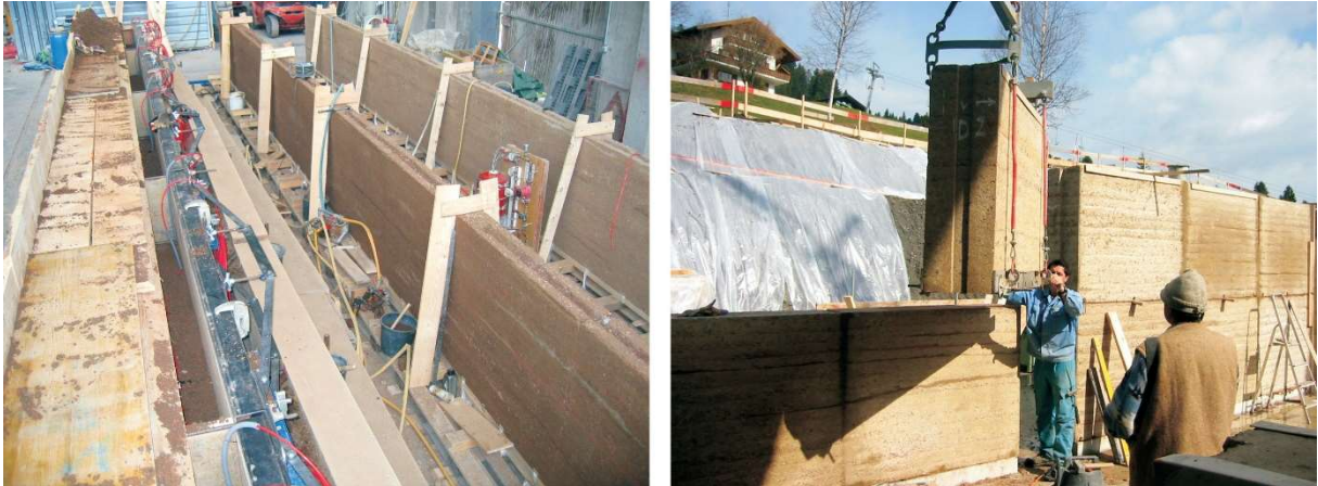
Figura 3.6 - Taipa pré-fabricada sendo produzida e instalada na obra. Fonte: Mag e Rauch, 2011.
