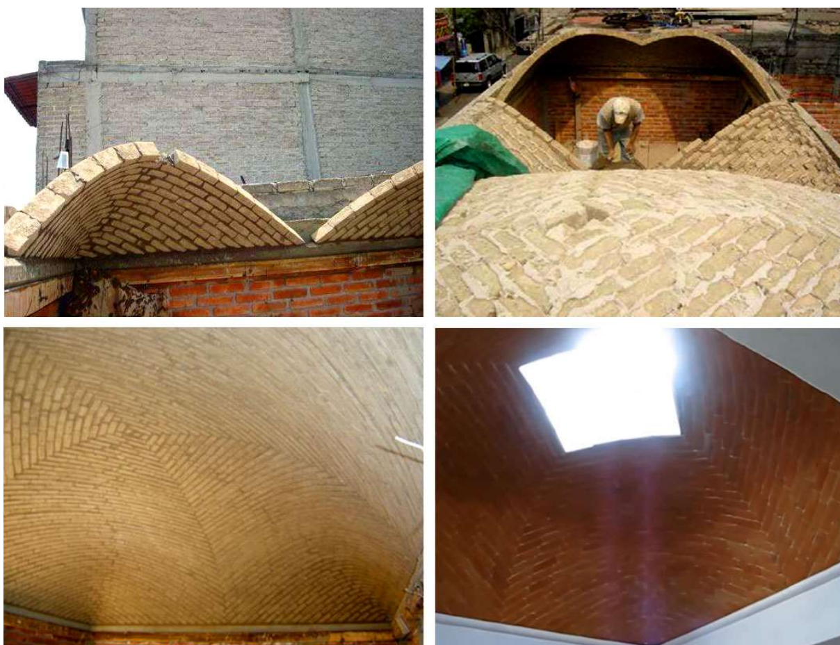
Figura 5.2: Processo construtivo da abóbada. Fotos: Ramón Aguirre.
