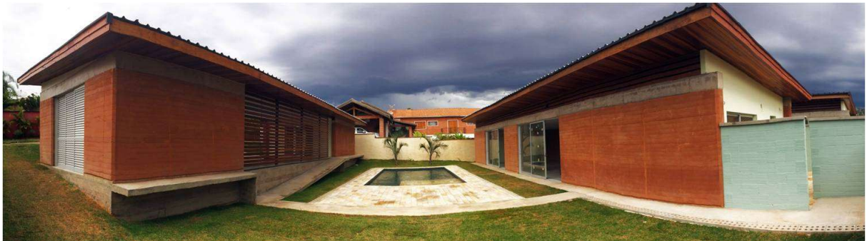
Figura 2.14 - Residência em Piracicaba, SP, executada em taipa de pilão em 2014. Projeto do arquiteto Márcio V. Hoffman.
