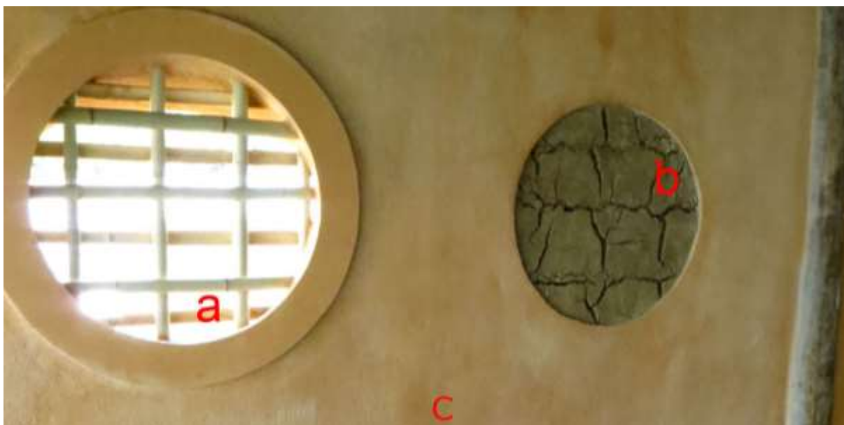
Figura A.11 – Parede executada em pau-a-pique mostrando suas três fases: entramados de bambu (a), preenchimento com terra e palha (b) e revestimento (c). Fonte: arquivo do autor.
