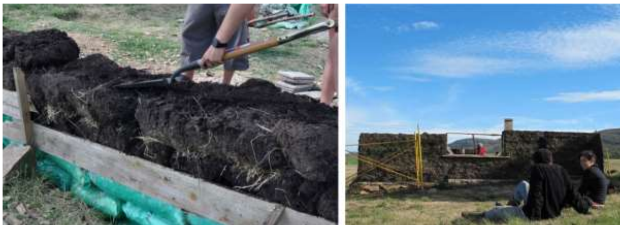
Figura A.8 – Construção de pequena edificação do projeto em Terrón, da Faculdade de Arquitetura da Universidad de la República, Uruguai. O objetivo do projeto é executar a obra ensinando aos alunos essa técnica tradicional. Fonte: arquivo Alejandro Ferreiro
