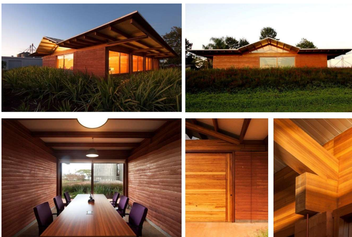
Figura 5.6: Escritório em fazenda em Taquaravaí (SP) - com painéis autoportantes em taipa de pilão e estrutura da cobertura em madeira laminada colada. Autores do projeto: Fernando Cesar Negrini Minto e Rafael Oliveira. Fotos: arquivo Fernando Cesar Negrini Minto.
