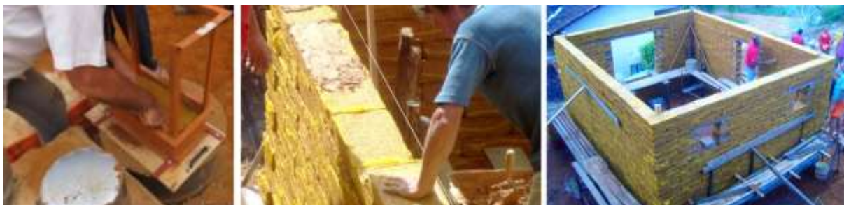
Figura A.6- Atividades de compactação do bloco e assentamento com a técnica desenvolvida pelo engenheiro Fernando Pacheco, que a denominou "brickeradobe". Fonte: Recriar com você, 2014.
