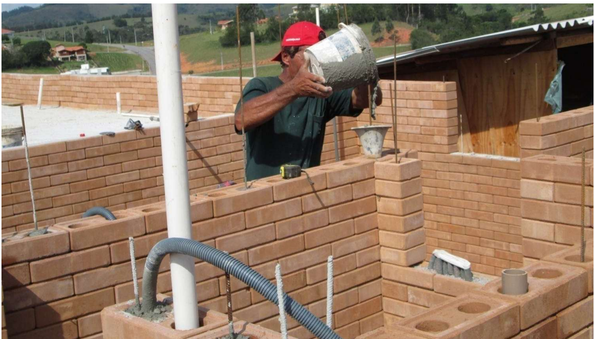
Figura 2.28 – Construção de alvenarias de BTC com furos. Enchimento dos furos com a barra de aço e micro concreto. A imagem mostra também as instalações passando pelos furos. Projeto do arquiteto Ricardo Piva. Fonte: Arquivo Ricardo Piva.
