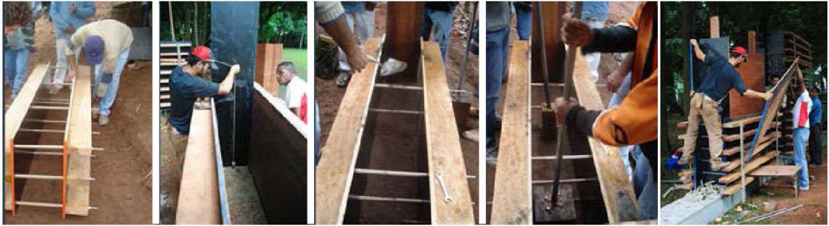
Figura 2.20 - Atividades de montar e aprumar a forma, espalhar a terra, compactar e desmontar a forma. Fonte: Neves e Faria, 2011.
