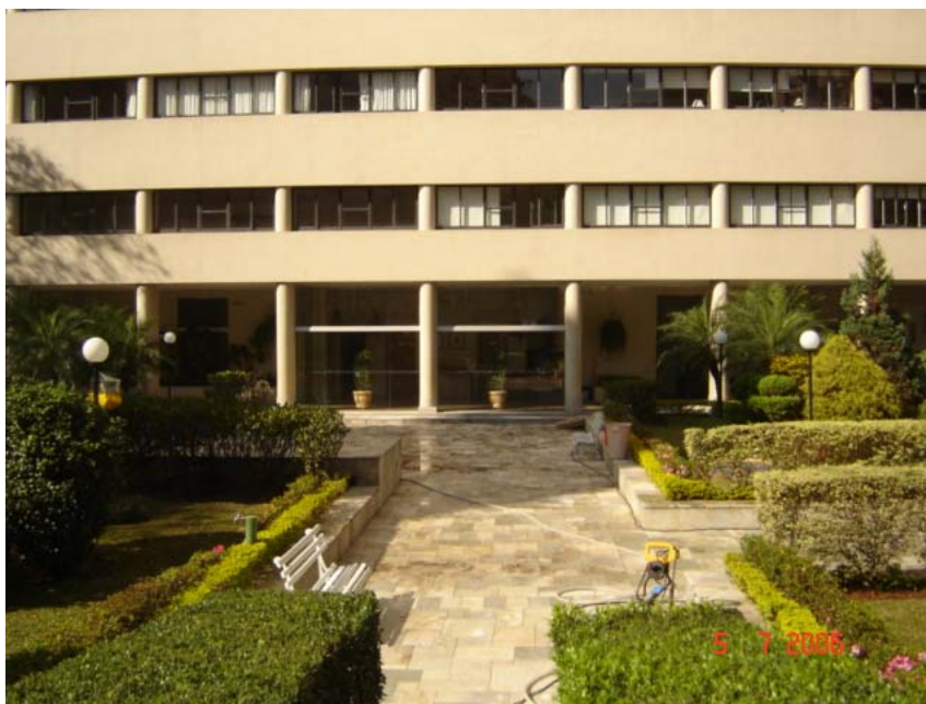
Foto 3.1 - Destaque para a fachada principal.
