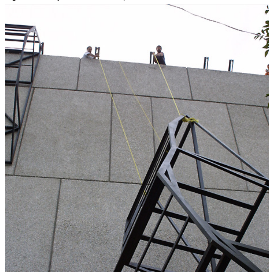
Figura 15 - Treliças metálicas sendo içadas.
