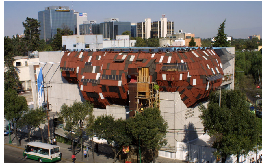
Figura 13 - Obra “Paracaidista, Av. Revolución 1608 bis” instalada na fachada no Museo Carrillo Gil.
