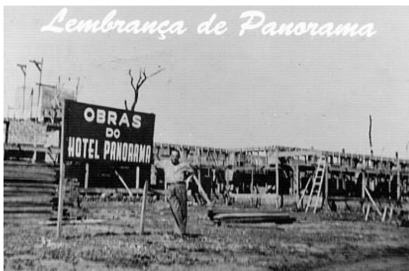
Figura 226: Obras do Hotel Panorama. Autor e data desconhecidos. Fonte: Prefeitura Municipal de Panorama, 2018.
