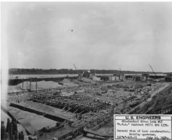
Figura 168: Acima, construção da barragem para geração de energia e navegação em Bonneville, Oregon. Abaixo, construção da eclusa e barragem no rio Mississippi. Ambos os projetos da PWA e do Corpo de Engenheiros do Exército dos EUA, em 1934-1935.
