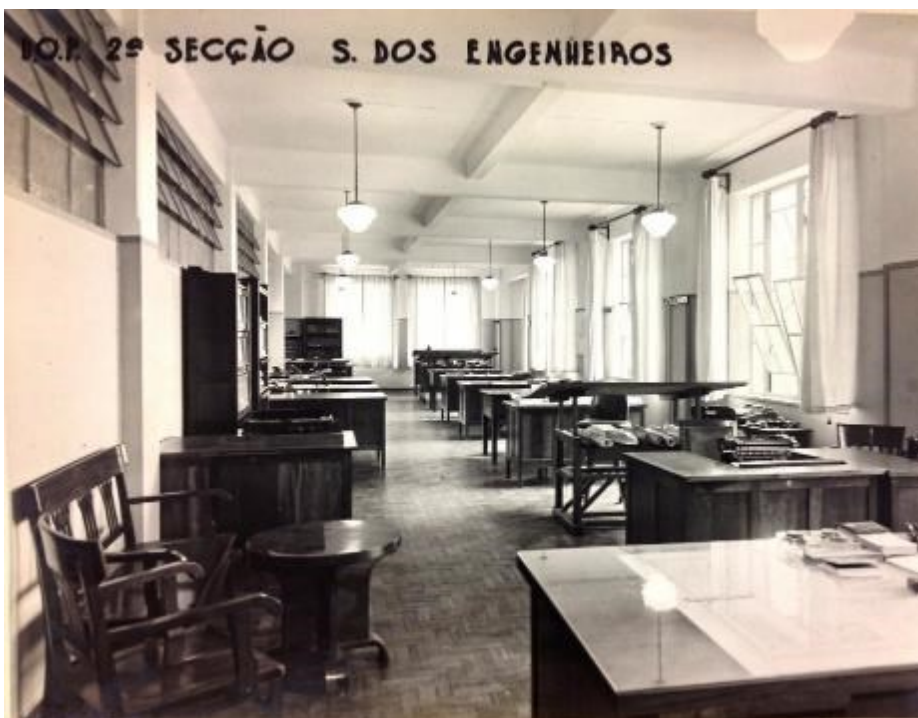
Figura 4: Secretaria de Viação e Obras Públicas. Diretoria de Obras Públicas-DOP. 2ª Seção. Sala dos Engenheiros. Fonte: Arquivo Público do Estado de São Paulo).
