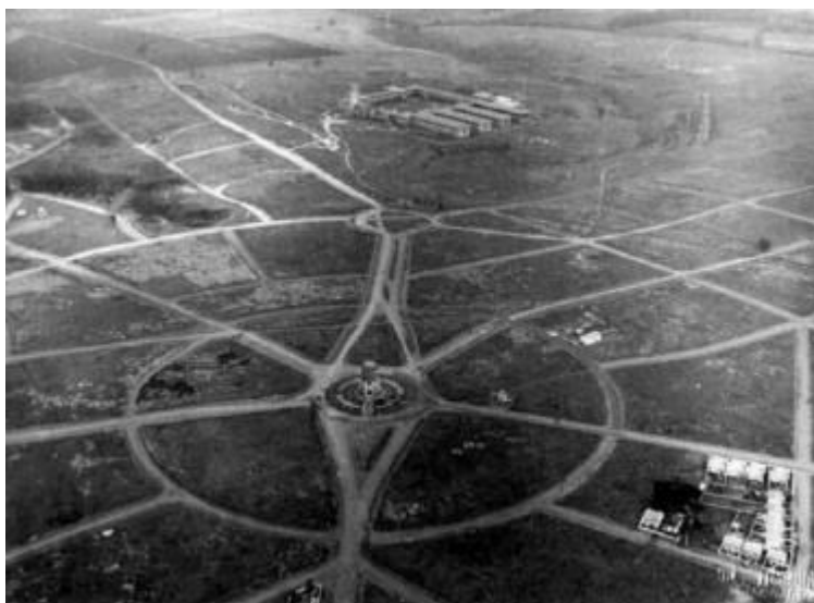
Figura 97: Vista aérea do Jardim Chapadão. Campinas, década de 1940.
