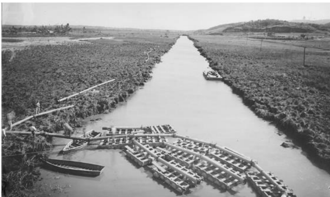
Figura 61: A retificação: primeiro corte do Canal do Rio Pinheiros em direção sul da Avenida Cidade Jardim. No lado esquerdo, trabalhadores na margem do rio, 1936. Fonte: Acervo Fundação Energia e Saneamento.
