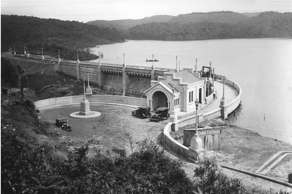
Figura 60: Barragem do Rio das Pedras, integrante do complexo do Projeto da Serra, 1929. Fonte: Acervo Fundação Energia e Saneamento.
