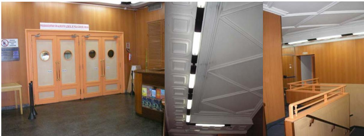
Fig. 178, 179 e 180 - Os novos acabamentos empregados não valorizam os remanescentes da ornamentação art déco. A porta da sala de projeção e os guarda-corpos possuem nova cor e os forros das salas de espera receberam novas luminárias. As paredes foram revestidas por um laminado.
