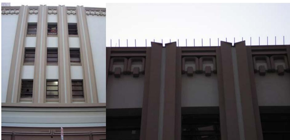
Fig. 176 e 177 - Detalhes da fachada lateral do antigo Cine Metro. O acabamento original foi coberto por outras pinturas.
