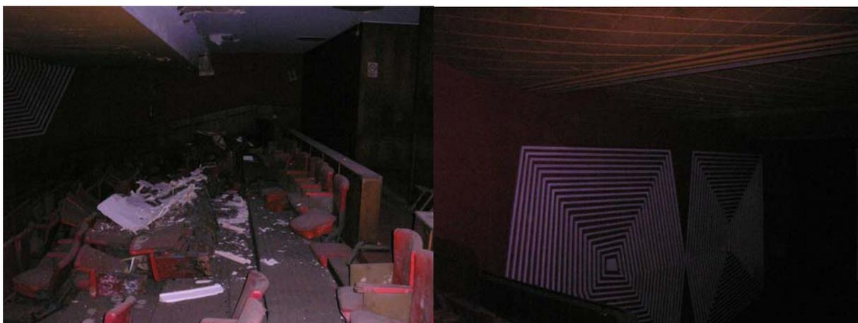
Fig. 163 e 164 - Cine Marrocos 2 (no antigo balcão): sala de projeção em estado precário de conservação. Observar os novos painéis acústicos colocados sobre as paredes.
