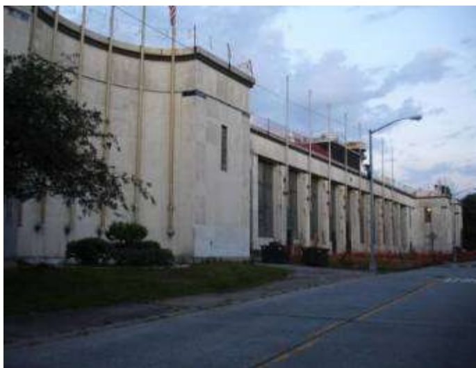
Figura 185 Vista frontal do Pavilhão da Cidade de Nova York, atual Museu de Artes do Queens (do autor, 2011)
