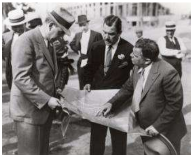
Figura 67 Robert Moses, comissário de parques da cidade de Nova York, Groven Whalen, presidente da Feira e o prefeito La Guardia inspecionam as obras no parque Flushing Meadows, 29 junho de 1936 (Fonte: Queen Art Museum)
