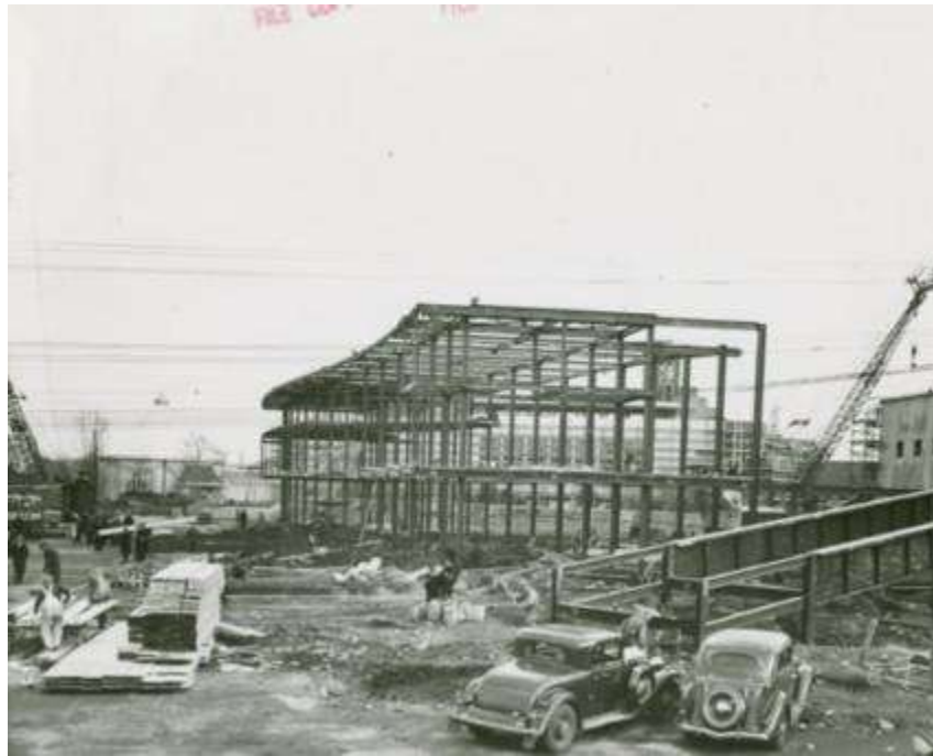
Figura 96 A malha em aço da estrutura revela que a estrutura segue a curvatura do edifício, a modulação ortogonal da estrutura foi rompida. A rampa construída em aço recebe revestimentos que engrossam seu guarda corpo. (Fonte: NYPL).
