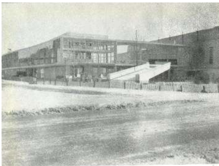
Figura 179 Vista da demolição a partir da Rainbow Ave. (Fonte: Vidal, 1942).
