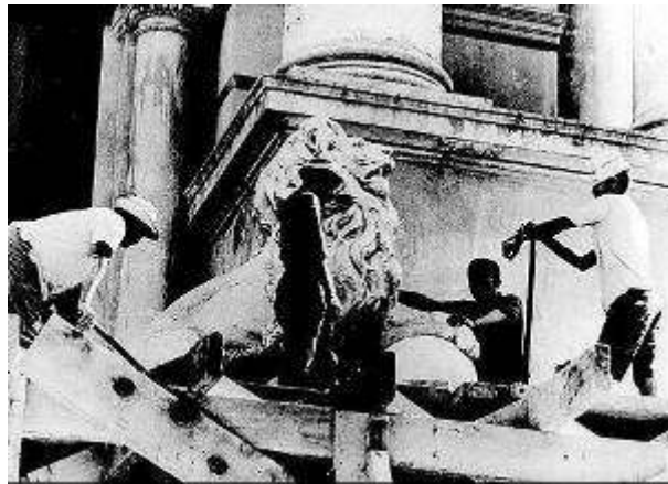
Figura 198: Palácio Monroe durante sua demolição, cerca de 1975. Fonte http://www.almacarioca.com.br/monroe.htm acessado em 12/10/2010.
