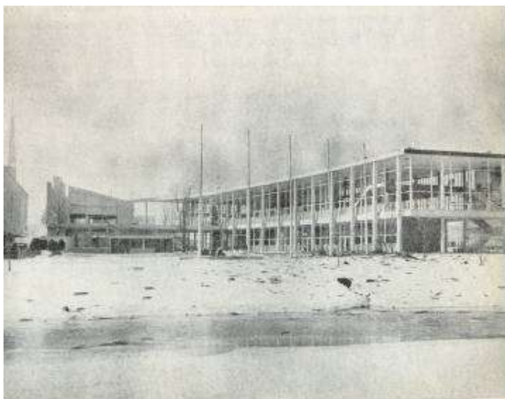
Figura 178 Vista da demolição a partir do córrego Flushing (Fonte: Vidal, 1942).
