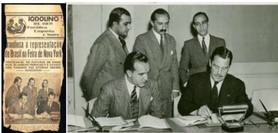
Figura 93 Recorte de O Globo de 6 de agosto de 1938: “A comissão que organiza a representação do Brasil na Feira de Nova York aprovou a construção do nosso Pavilhão, em projeto de Lucio Costa, que deverá estar terminado em fins de dezembro para que em janeiro sigam os primeiros mostruários. A obra está orçada em seis mil contos de réis”. Em pé, Lucio Costa e Oscar Niemeyer assistem Greven Whalem em preto assinar a aprovação do projeto. (Fonte: esq: IACJ, dir. New York Public Library - NYPL).
