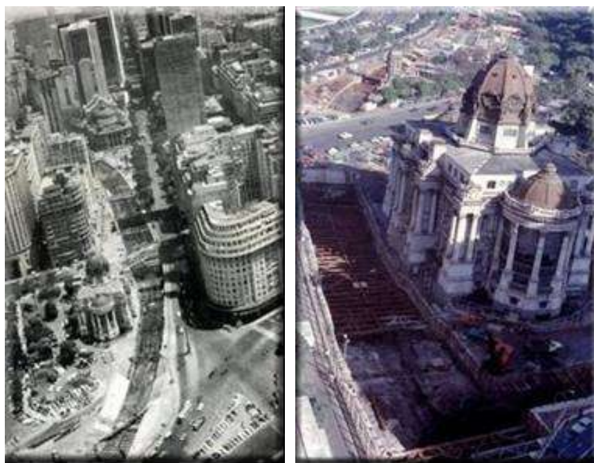
Figura 196: Palácio Monroe durante as obras do Metrô, cerca de 1975. (Fonte http://www.almacarioca.com.br/monroe.htm acessado em 12/10/2010).
