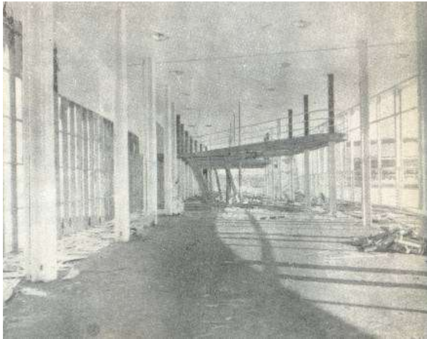
Figura 180 Vista interna da demolição, estrutura em aço e fechamento de gesso acartonado (Fonte: Vidal, 1942).
