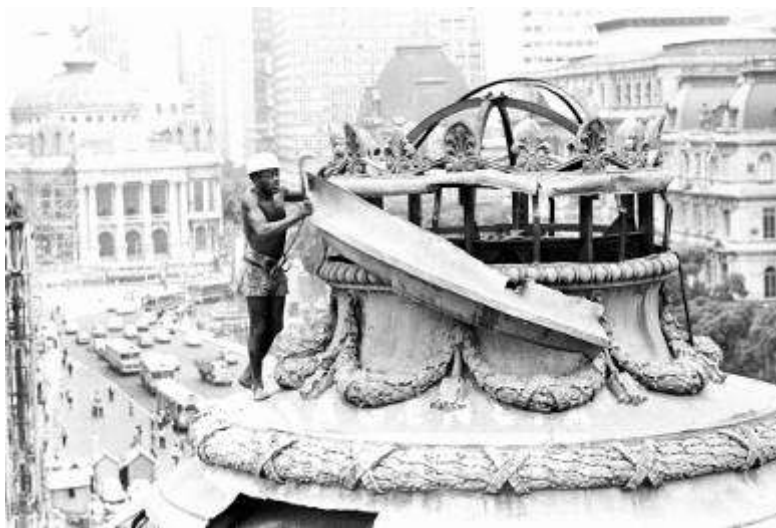
Figura 187 Demolição do Palácio Monroe, 22.01.1976 - Anibal Philot (Fonte: Agência O Globo)
