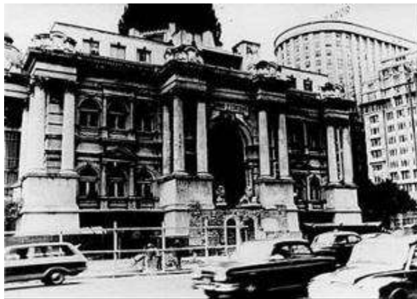
Figura 199: Palácio Monroe durante sua demolição, cerca de 1975. Fonte http://www.almacarioca.com.br/monroe.htm acessado em 12/10/2010.
