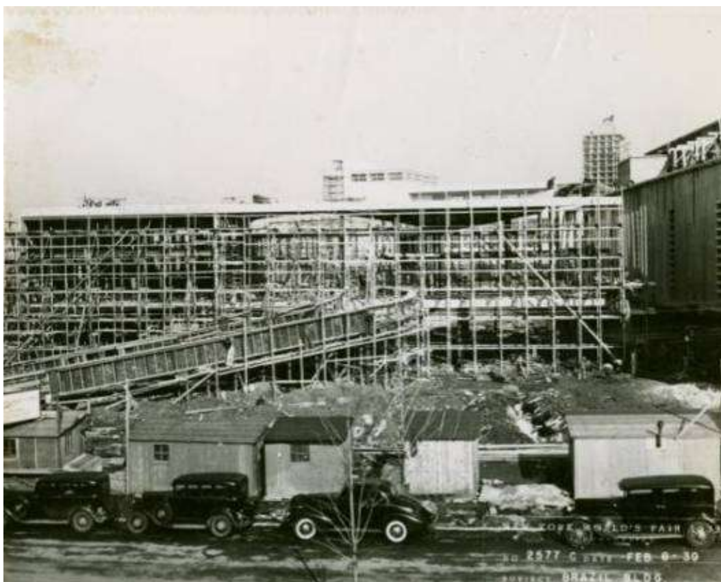
Figura 95 imagem com data de 8 de fevereiro de 1939, o cimbramento na fachada frontal sugere que a mesma não foi construída com estrutura em aço. A laje que se inclina em direção ao auditório, ainda não construído, sugere que a mesma foi moldada in loco (Fonte: NYPL).
