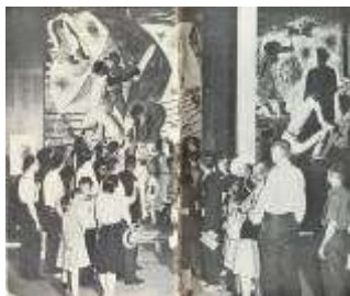
Figura 154 Painéis de Portinari (Fonte: Vidal, 1942).
