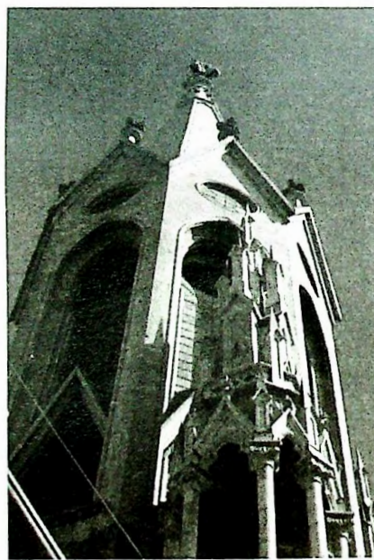
Catedral Metropolitana de São Paulo Torreões construídos Fotos acervo do arquiteto
