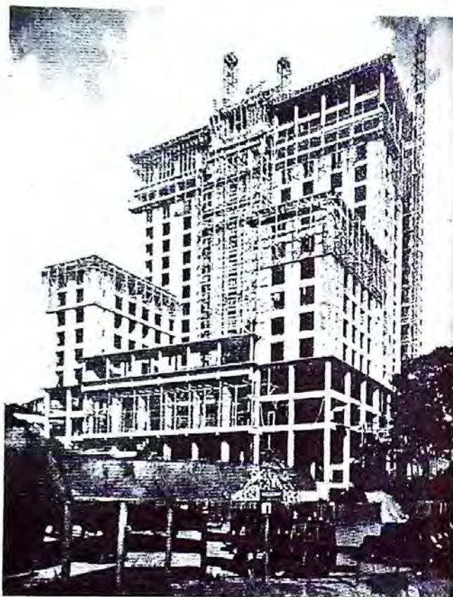
Edifício Palácio Mauá, em obras. ( Engenharia , nº94, 1950:451)
