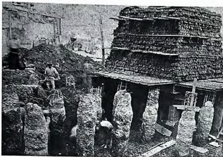
Teste de carga nas estacas do edifício executado pelo Instituto de Pesquisas Tecnológicas (IPT). (Arquivo do IPT)
