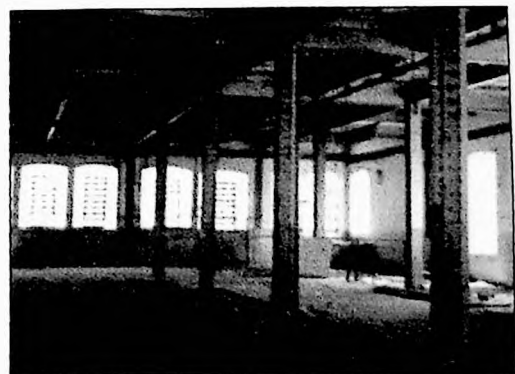
36c. Interior do edifício da fiação em 2001. Estrutura metálica e planta livre.
