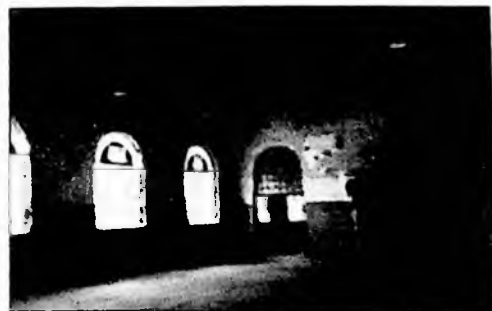
26c. Galpão voltado para rua da Mooca
