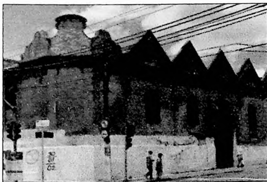
33b. Edifício A. Esquina entre rua dos Trilhos e rua Visconde de Laguna. 2001. Observar Fig 12
