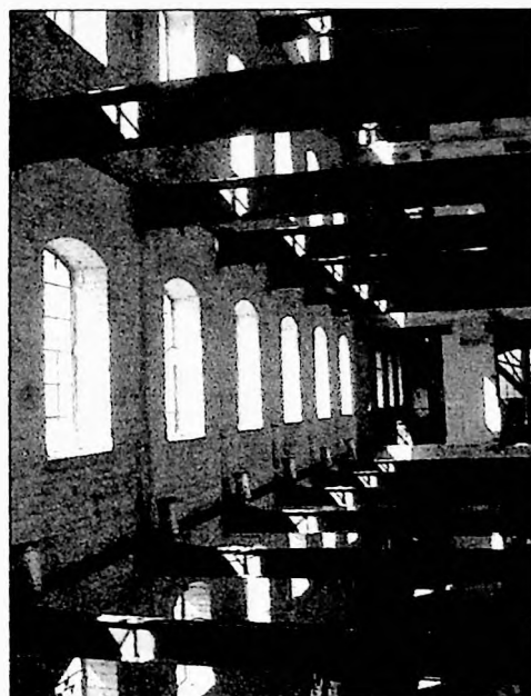
37b. Edifício do moinho. Grandes vigas metálicas atravessam o edifício no sentido transversal. 2004
