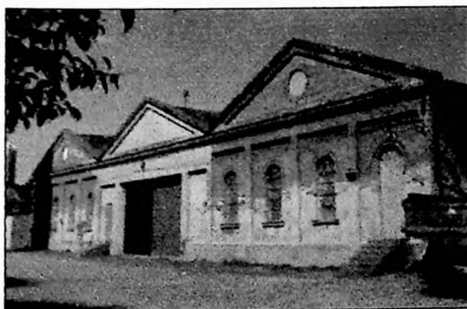
39a. Galpão RFFSA. Fachada voltada para o acesso da Estação Mooca. Situação em 1996.
