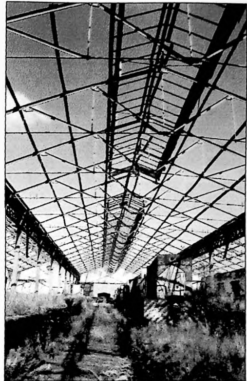
39e. Interior do galpão. Situação em 2003.
