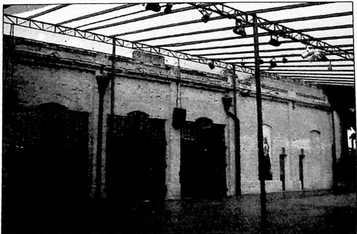
37f. Galpões anexos ao edifício do moinho. Hoje utilizados para festas e eventos. A cobertura externa é intervenção recente
