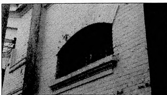
27c. Detalhe. Abertura da elevação original
