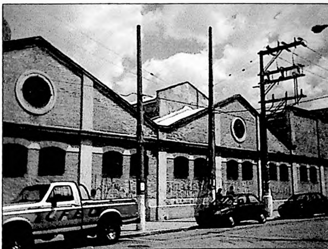
31a. Primeiro edifício da São Paulo Alpargatas S.A. , localizado na rua Dr. Almeida Lima. Construído em 1907 pelo arquiteto italiano Julio Michele. Fachada protegida pelo COMPRESP. Foto de 2003.
