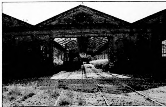
39b. Fachada posterior. Situação em 2003.
