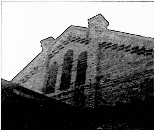
29c. Detalhe – aberturas nos frontões para ventilação
