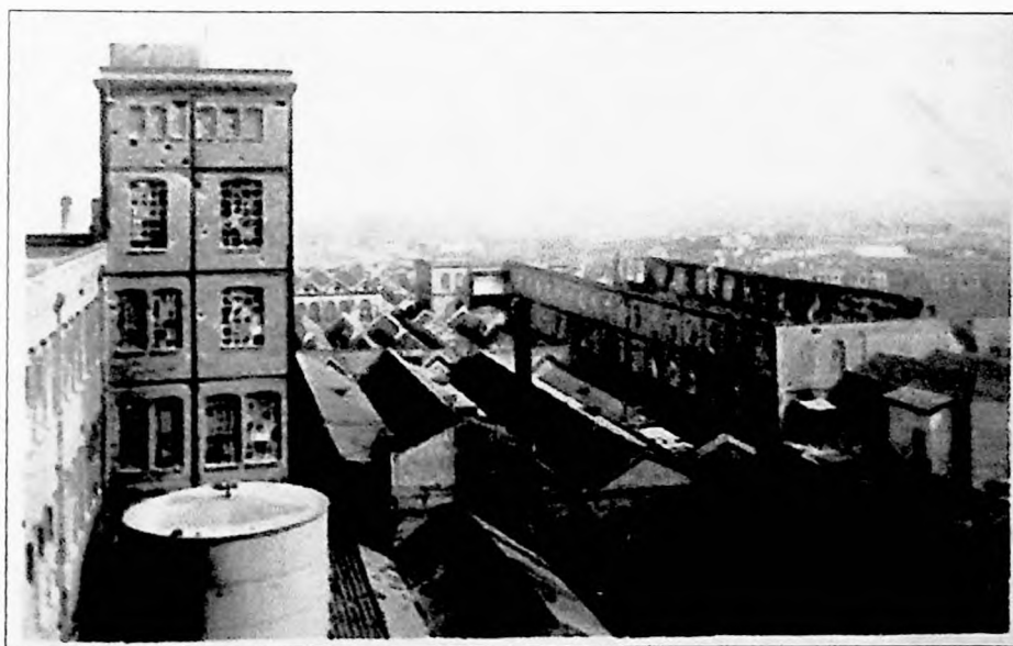
35b. À esquerda, torre do edifício da fiação. À direita, edifício demolido na década de 1920. Efcitos da revolução de 1924. (Acervo do Museu da Polícia Militar do Estado de São Paulo)
