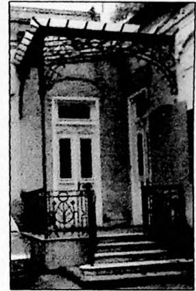
33e. Edifício B – Antiga residência do administrador
