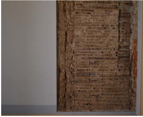
Imagem 15. Detalhe de janela arqueológica mantida aberta na parede do primeiro pavimento. Acervo da autora.
