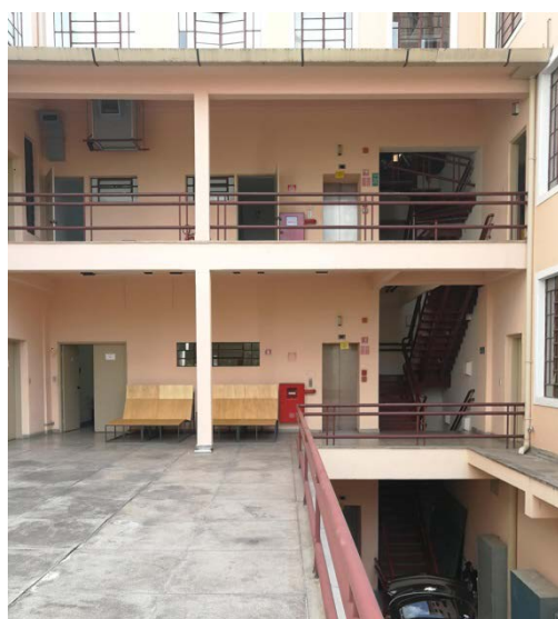
Imagem 7. Detalhes da fachada do edifício anexo. Autoria: Rafael Itsuo, 2019.
