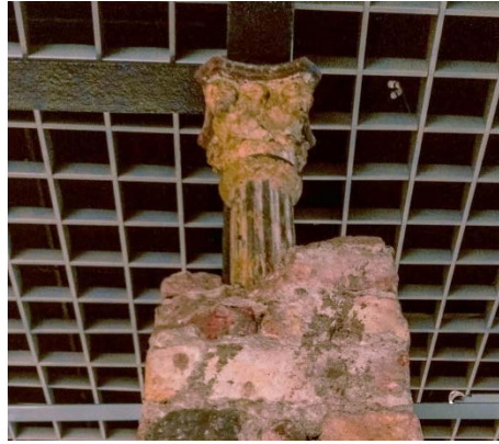
Imagem 16. Detalhe da solução dada para evidenciar as diferentes constituições dos pilares. Ao fundo é possível notar o revestimento instalado no forro do pavimento térreo. Acervo da autora.
