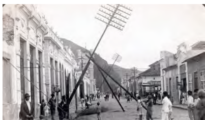
Figura 2.96. Instalação de cabeamento telefônico. S.d.
