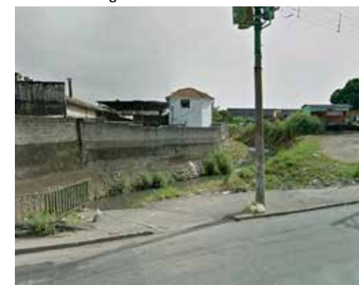
D: Avenida Itaquera: córrego canalizado ao ar livre
