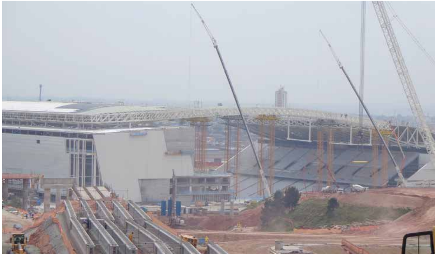
Figura 76: Arena Corinthians em obra. Foto: Patrícia Akinaga, 23 outubro de 2013.
