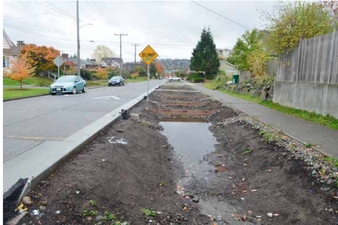
Figura 40: Imagem de implantação do jardim de chuva das ruas 67th Street e 28th Avenue (NW). Foto: Priscilla Tiba.
