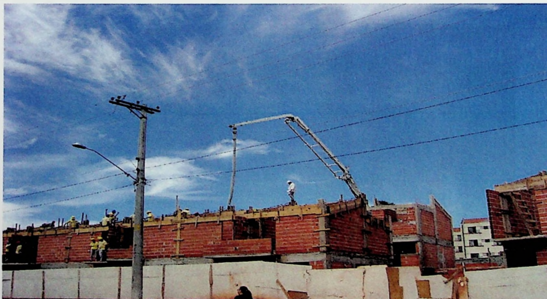
Figura 7: Concretagem das colunas do Mutirão City Jaraguá
