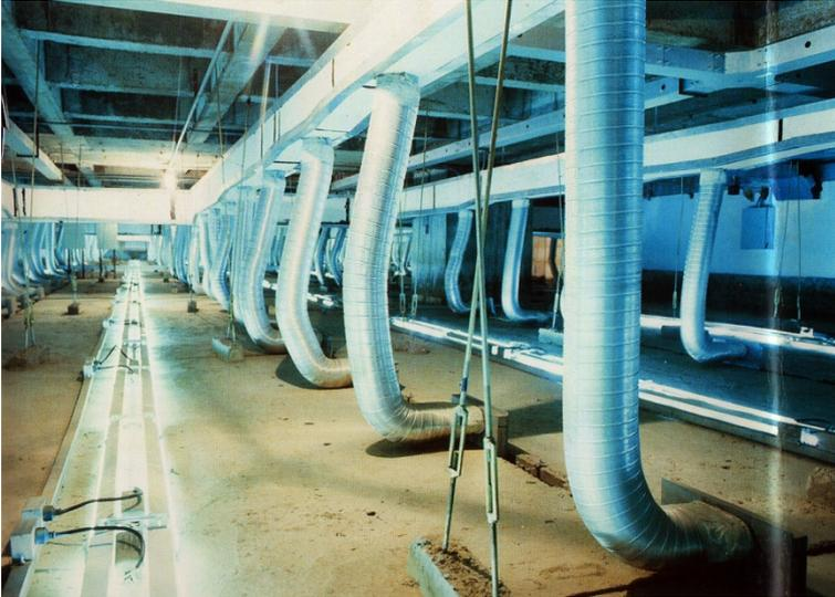
Ilustração 76 - Foto do piso intermediário em placas de concreto pré-moldados atirantados à estrutura. Com dois metros de pé-direito, vê-se a tubulação de ar-condicionado, calhas de iluminação do piso abaixo
