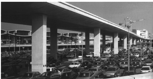
figura 6.33c: Terminais 2 do Aeroporto de Paris/CDG. Área de estacionamento entre os terminais 2, sobre os pavimentos inferiores de estacionamento e sob o sistema viário que conduz ao terminal intermodal de transportes.
