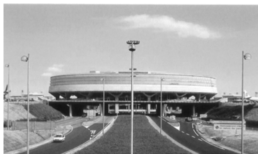
figura 4.13: Terminal 1 do Aeroporto de Paris/CDG
