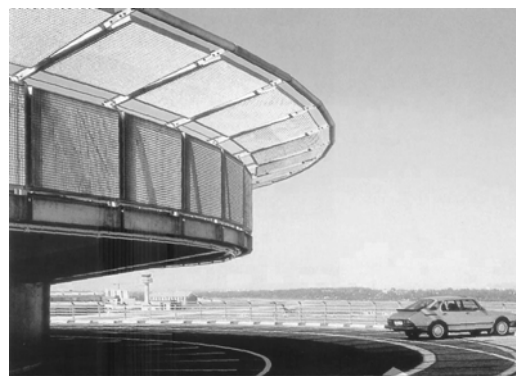
figura 6.34c: Edifício garagem, anexo ao terminal e torre circular de acesso.
