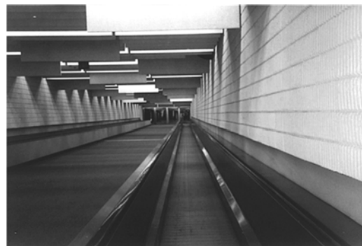
figura 3.13: Túnel de Atlanta, que interliga o Terminal Central com os terminal de páteo. Paralelamente a esse túnel, destinado a pedestres, e equipado com tapetes rolantes, correm os veículos do Sistema de Transporte Automático de Passageiros
