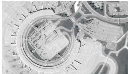
figura 6.36b: Aeroporto de Kansas City. Um dos três terminais de passageiros construídos inicialmente.
