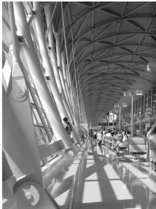
figura 6.51: Aeroporto de Kansai – Area de embarque. Esse espaço contínuo e monumental se desenvolve ao longo dos 1.700 metros de extensão do terminal. Como características marcantes, podem ser assinaladas, além dessa extensão, o teto curvo que se transforma em caixilharia envidraçada, proporcionando ampla visão sobre o pátio de aeronaves.
