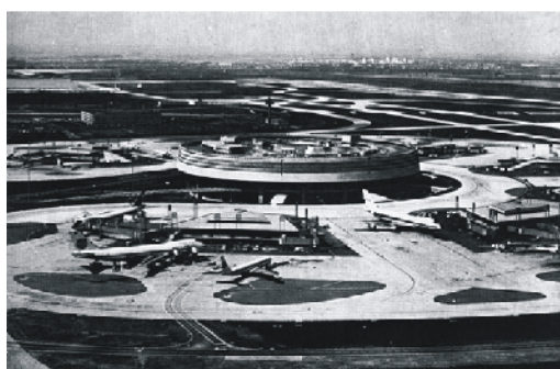
figura 3.21: Terminal 1 do Aeroporto de Paris/ CDG
