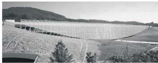
figura 6.35c: Vista do edifício garagem
