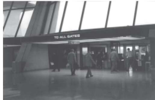
figura 6.38b: Aeroporto de Washington/Dulles. Foto interna do saguão mostrando o embarque dos passageiros nos “mobile lounges”. Sobre as portas, sob teto relativamente baixo, observa-se, os caixilhos inclinados da fachada do lado ar.
