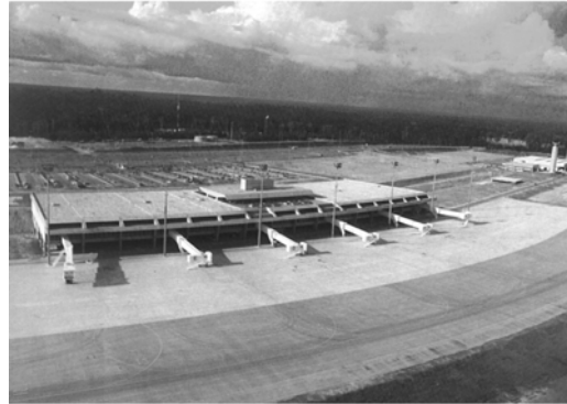
figura 4.19: Aeroporto Internacional de Manaus Vista do terminal
