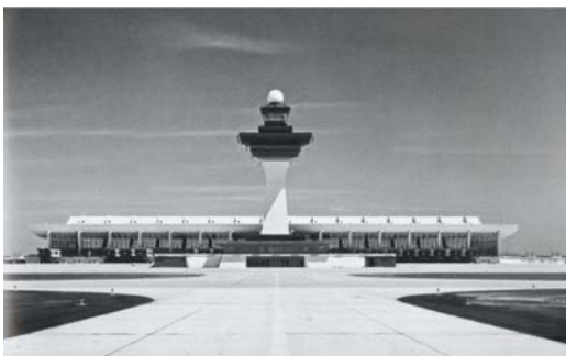
figura 3.24: Terminal de Passageiros do Aeroporto de Washington/Dulles
