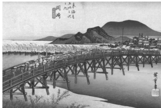
figura 5.7: Ponte Yahagui , em Oazaki
