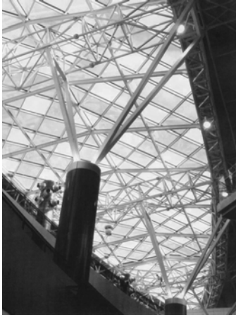
figura 6.10: Aeroporto de Recife/Guararapes – Ubirajara Moretti
