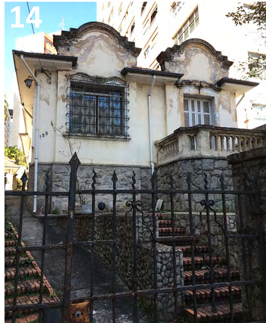
Denominação: - Endereço: Al Joaquim Eugênio de Lima, 159 Distrito/Sub: Bela Vista, Sé Tombamento: Res. 22/02 TDC | 03 transferências entre 2011 e 2013 | Potencial total: 1.294,00 m 2 | Potencial disponível: 41,36 m 2 Uso atual: Residência Estado de conservação: ruim
