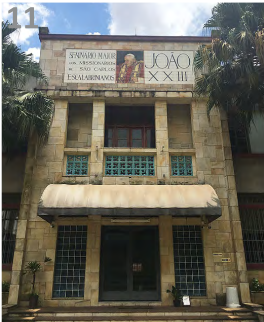
Denominação: Instituto Cristóvão Colombo Endereço: R Dr Mário Vicente, 1108 Distrito/Sub: Ipiranga, Ipiranga Tombamento: Res. 06/07 TDC | 08 transferências entre 2009 e 2012 | Potencial total: 62.291,00 m 2 | Potencial disponível: 16.345,47 m 2 Uso atual: Seminário da Igreja Católica Estado de conservação: bom
