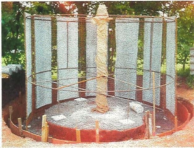
Figura 73 - Início da montagem dos setores de parede pré-moldados sobre o anel de fundação, utilizando um gabarito metálico para manter o posicionamento correto dos elementos.
