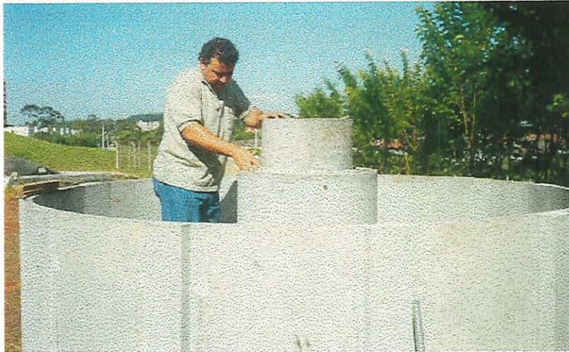
**Figura 80 - Colocação da câmara de distribuição do afluente sobre a câmara de coleta do efluente**
