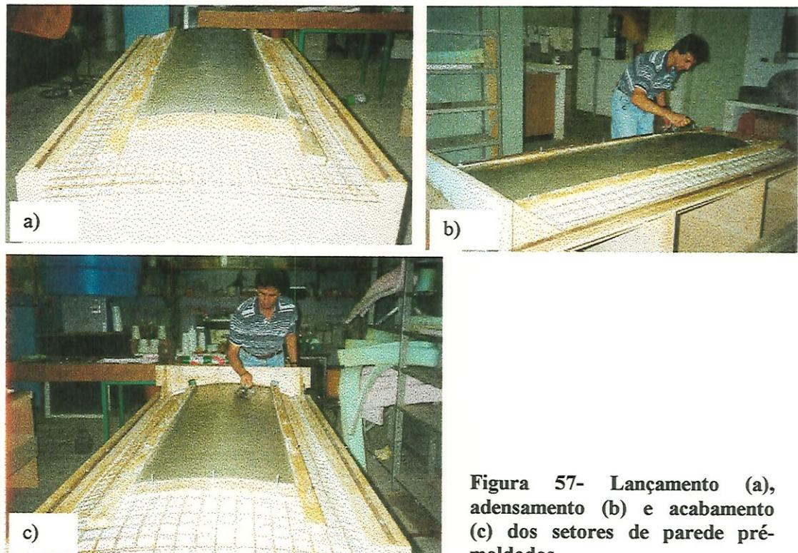
**Figura 57-** Lançamento (a), adensamento (b) e acabamento (c) dos setores de parede pré-moldados
