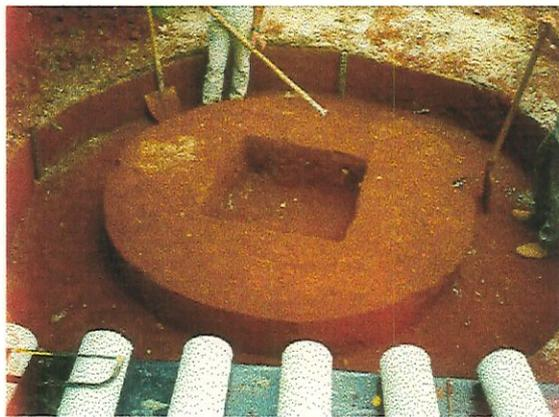
**Figura 71-** Escavação da sapata, do anel e da laje de fundo.
