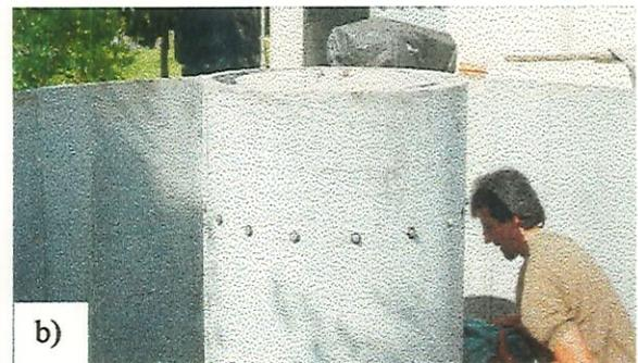
Figura 78- a) A câmara de coleta do efluente é içada com auxílio de um caminhão munke. b) Detalhe do encaixe da câmara de coleta do efluente sobre o pilar central (parafusos).
