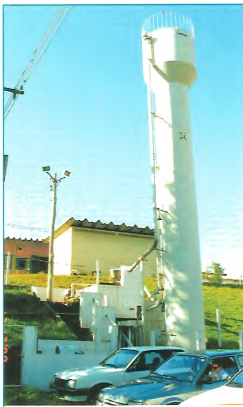
FIGURA 29 – Reator anaeróbio de leito expandido instalado no campus da EESC/USP (MENDONÇA, 1999).
